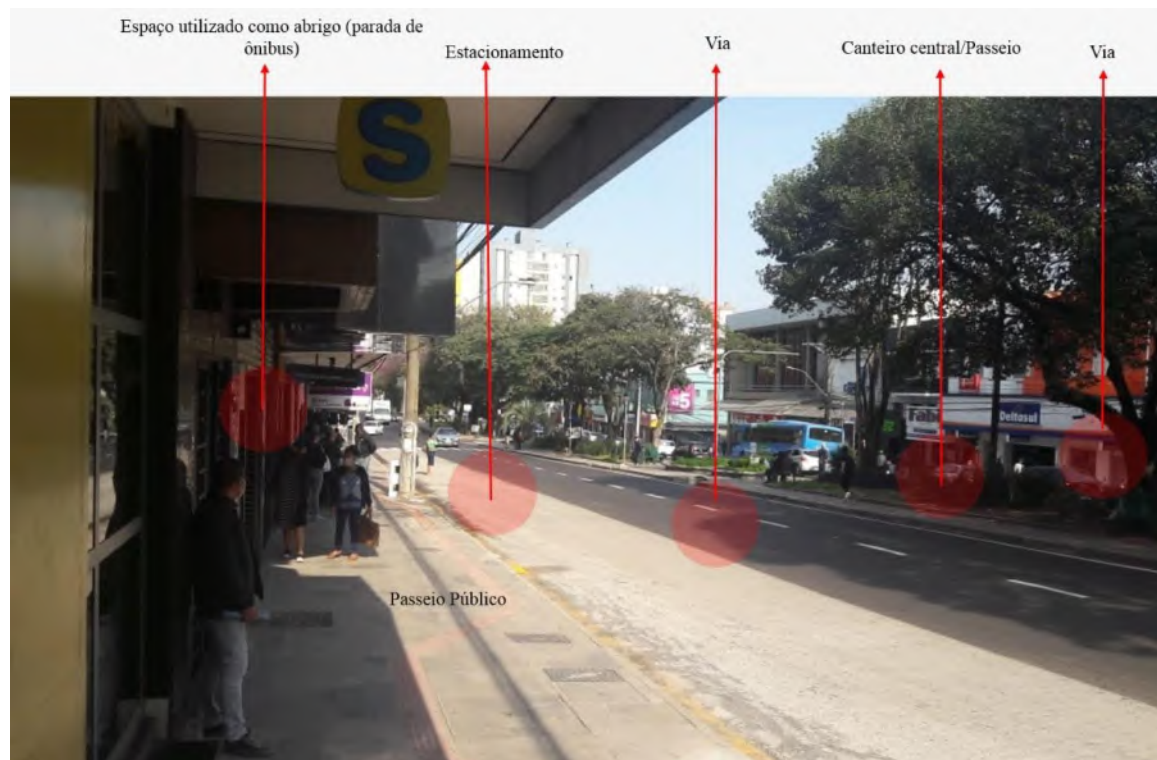
Fig. 5 Avenida Brasil: situação atual
