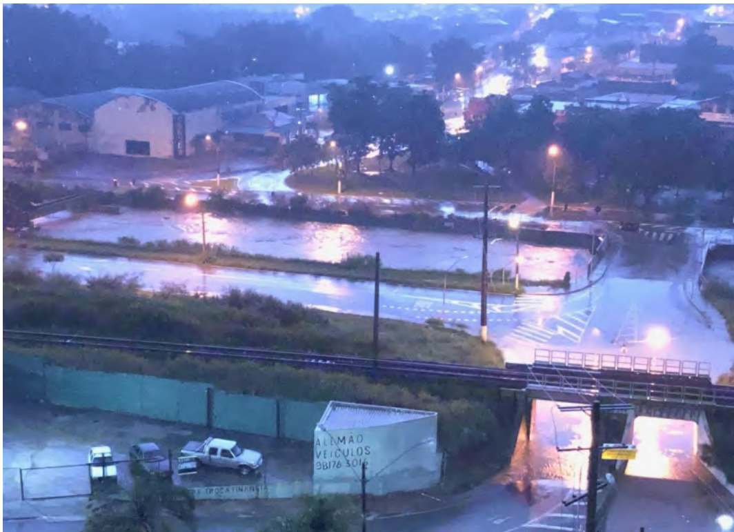
Fig. 3 Área conhecida como Ponte Preta, em dia de grande quantidade de chuvas, apresentando problemas de drenagem, no início de janeiro, 2020.
