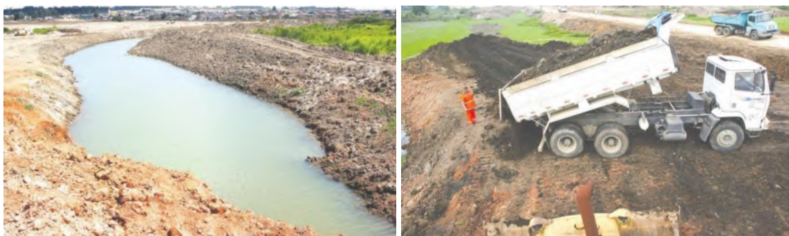
Fig. 7 Construção do canal de macrodrenagem e diques em 2007
