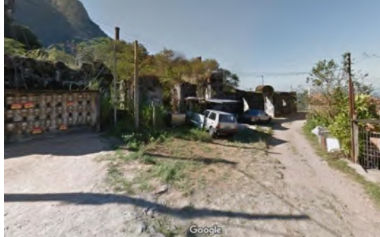
Fig. 2 Ruína da Fábrica Cometa no Meio da Serra, Petrópolis. Fonte: Google.
