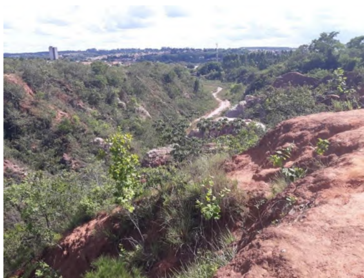
Figura 4 – Erosão Hídrica do tipo boçoroca ou voçoroca
