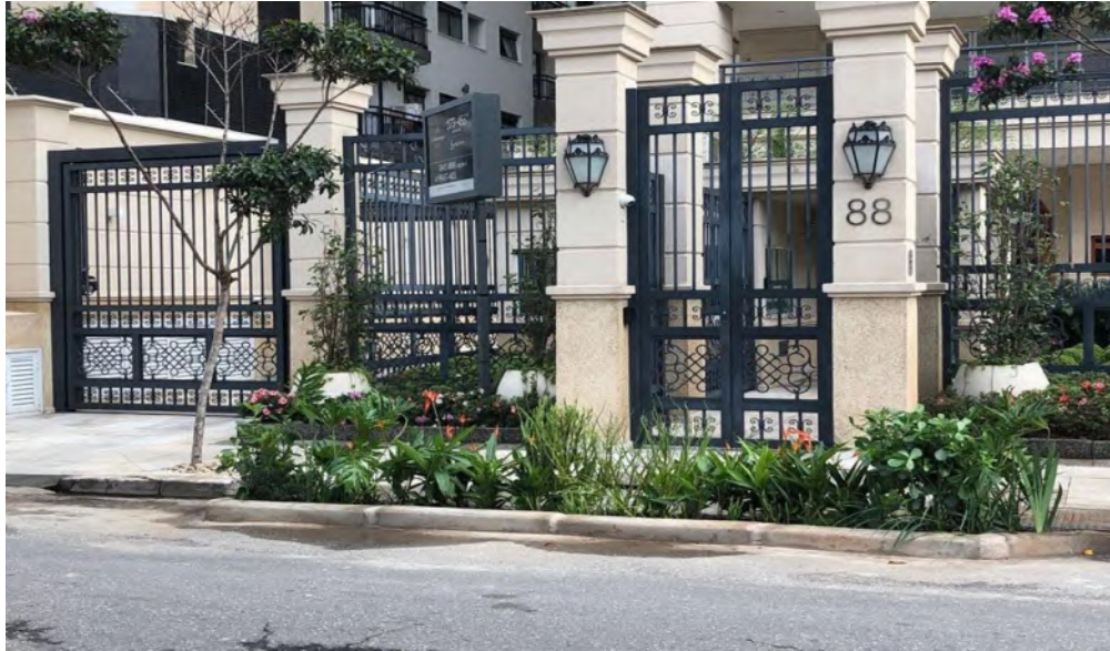
Fig. 3 Canteiro Pluvial na Rua Fiandeiras (iniciativa do condomínio). Foto: Nik Sabey. Disponível em: http://verdesp.com.br/jardim-de-chuva/ . Acesso 20/06/2020.
