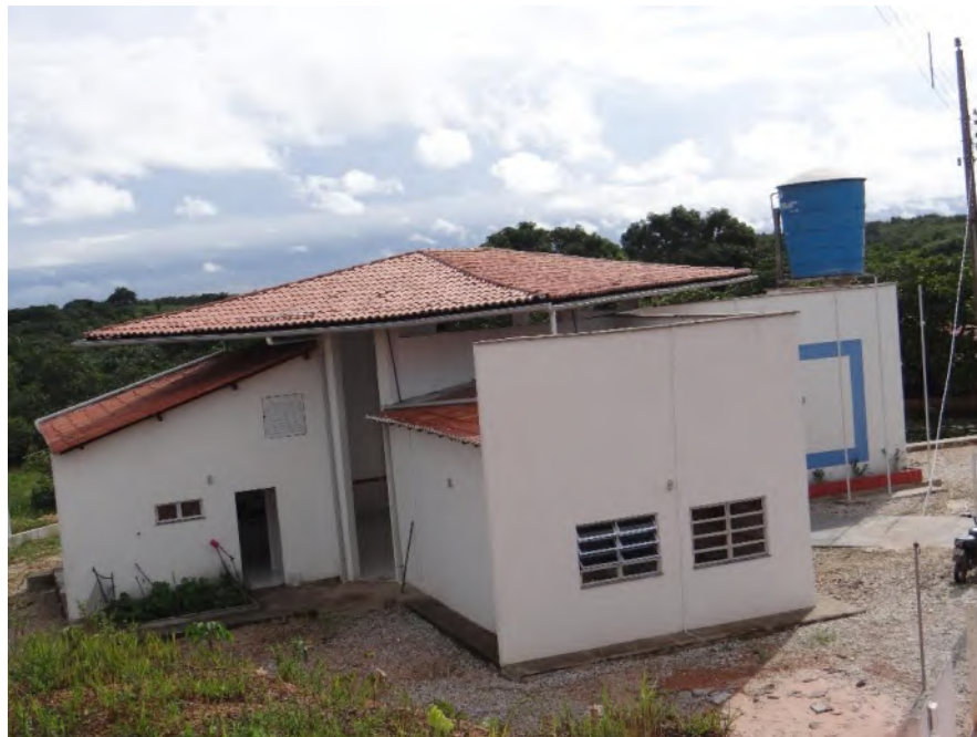
Fig. 6 Telhado do pátio sobre o telhado das salas de aula
