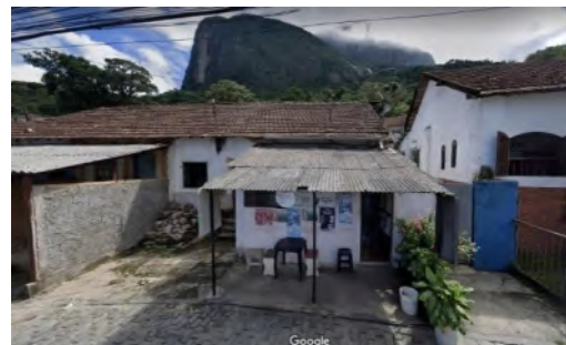
Fig. 7 Casa da tipologia da vila operária com expansão. Fonte: Google.
