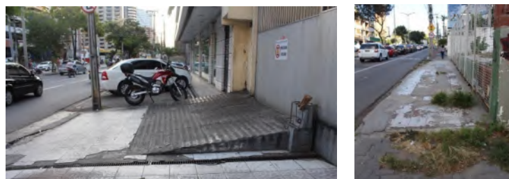
Fig. 4 Calçada interrompida por rampa para veículos. / Fig. 5 Condições de manutenção de uma calçada adjacente a um lote sem uso. Fonte: Acervo Pesquisa.
