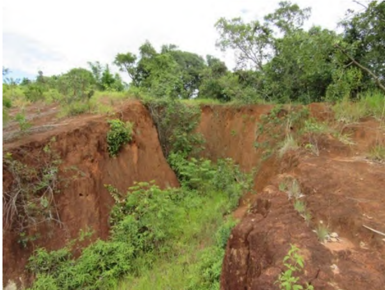
Figura 3 – Erosão Hídrica do tipo ravina
