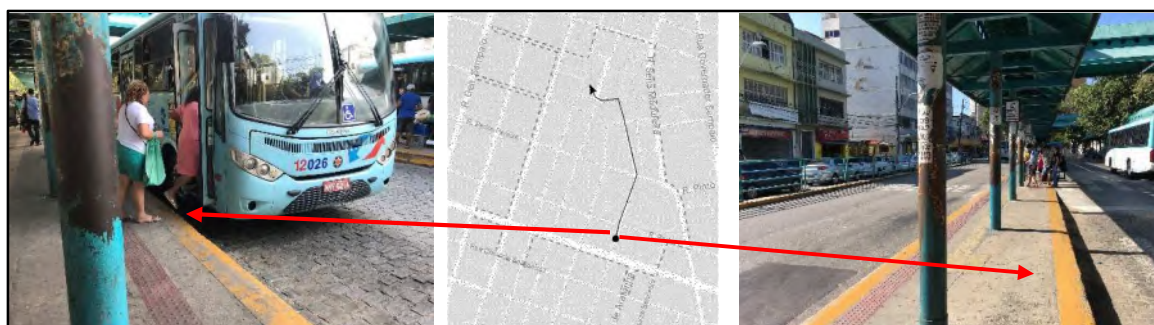
Fig. 9 Espaço entre ônibus e plataforma e ausência de piso tátil
