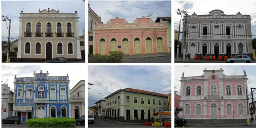
Fig. 5 Algumas das fachadas que compõe a Praça Marechal Floriano Peixoto, Rio Novo, Minas Gerais.
