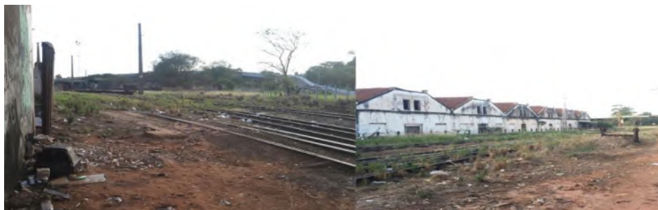
Fig. 9 Montagem com imagens dos trilhos próximos à Estação ferroviária de Bauru – deriva no centro 8
