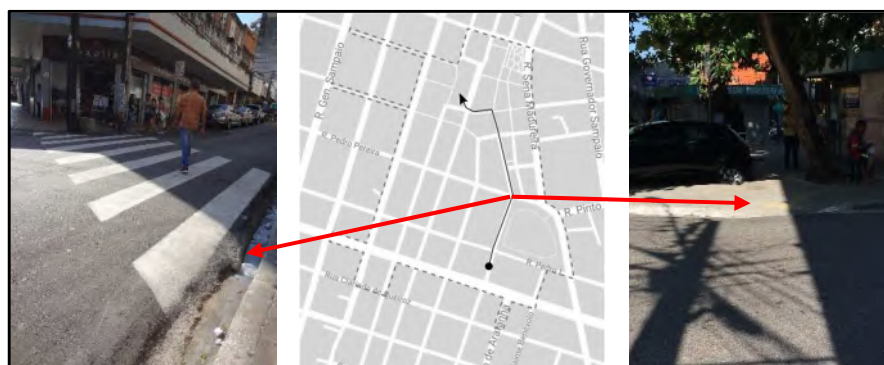
Fig. 6 Ausência de rebaixamento e guia rebaixada sem nivelamento com via
