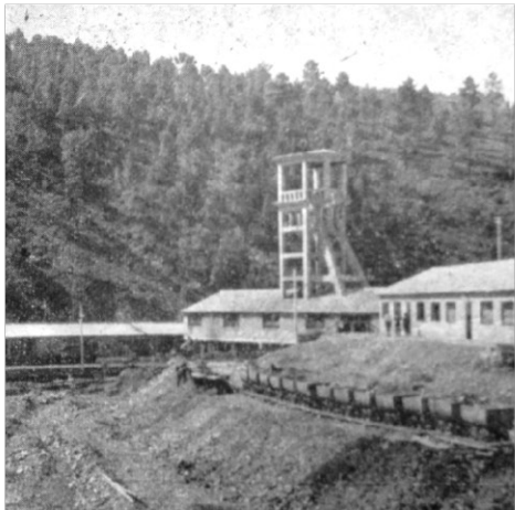
Fojo - Cavalete e anexos do Poço do Fojo (1952)
