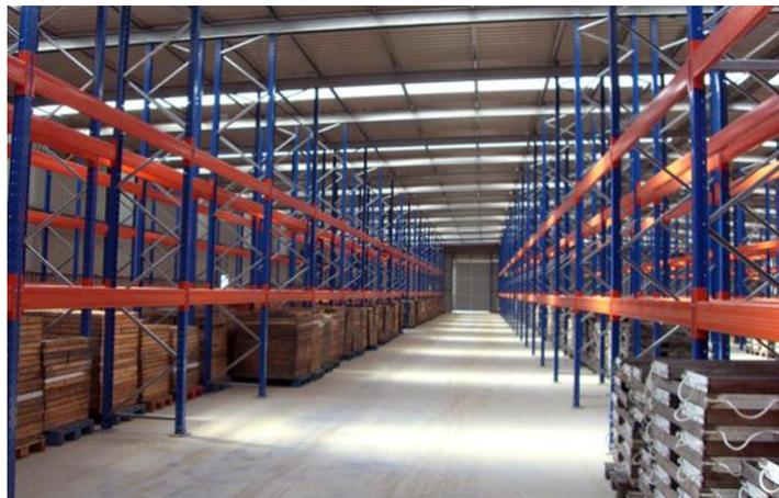
*Figura 6 - Sistema de armazenagem do tipo autoportante (Fonte:Nortemonta).*
