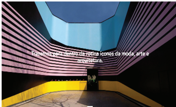
Figura 23 - Imagens do recuo da fachada da Galeria Melissa em São Paulo, Brasil.
