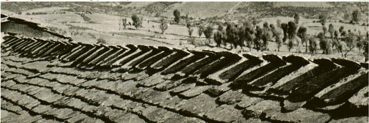
Fig.139 Varge. Cume do telhado da igreja ■
