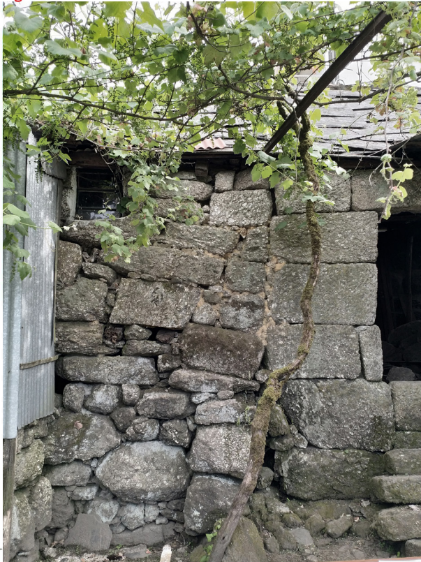
Fig.130 Paredes de alvenaria em pedra, caso de estudo ■
