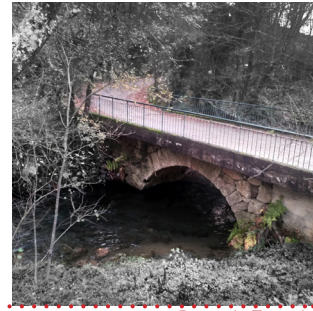
Ponte da Tornada
