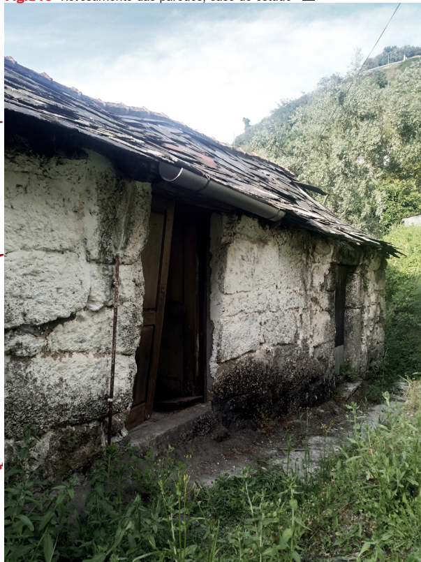
Fig.140 Revestimento das paredes, caso de estudo ■
