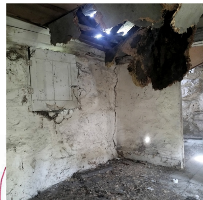
Fig.152 Sala/Quarto, Interior. Caso de estudo ■
