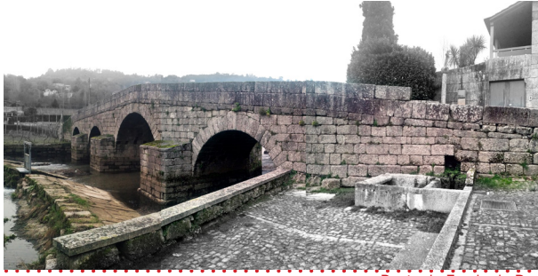
Ponte de Fundo de Rua
