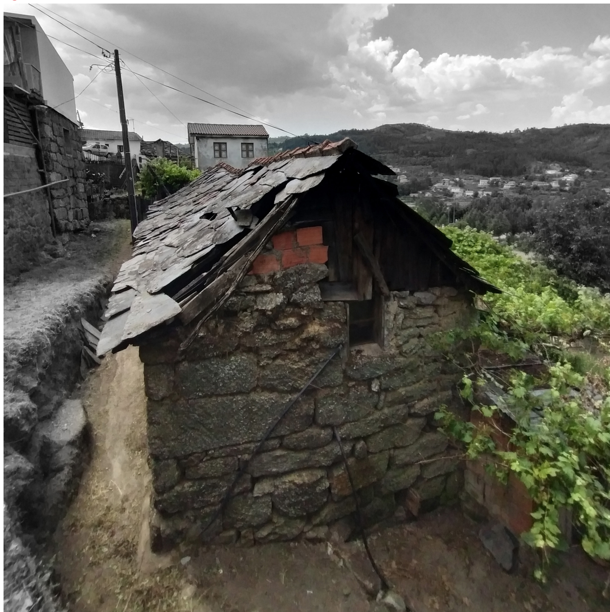
Fig.73 A Casa de Barral
