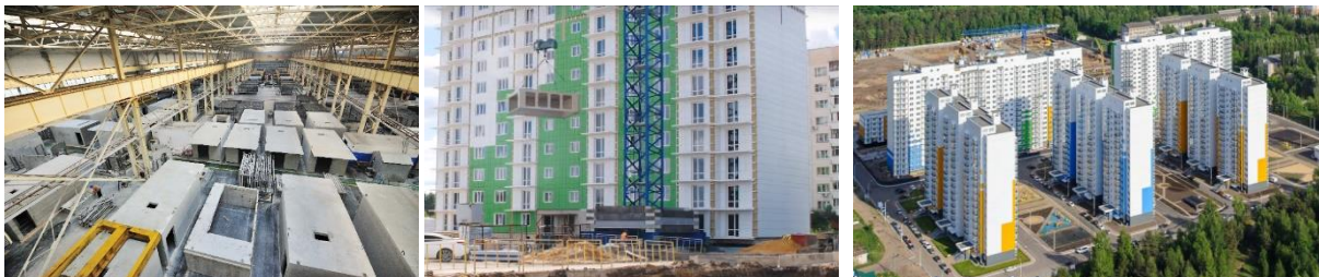
Figura 48. Pré-fabricação de apartamentos na empresa Vybor-OBD e construção de edifícios residenciais modulares (VYBOR-OBD, 2015) (Generalova et al., 2016)
