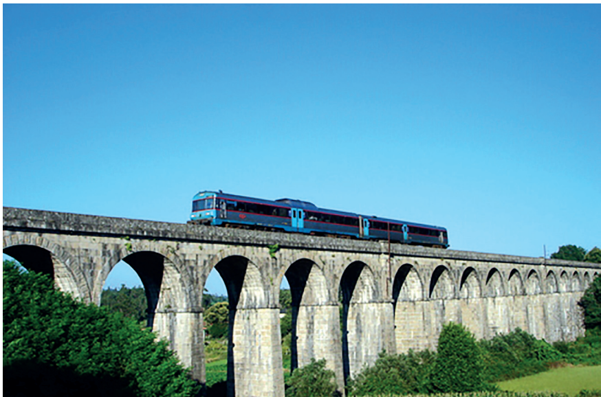
Viaduto ferroviário "Ponte Seca" Durrães, 2004
