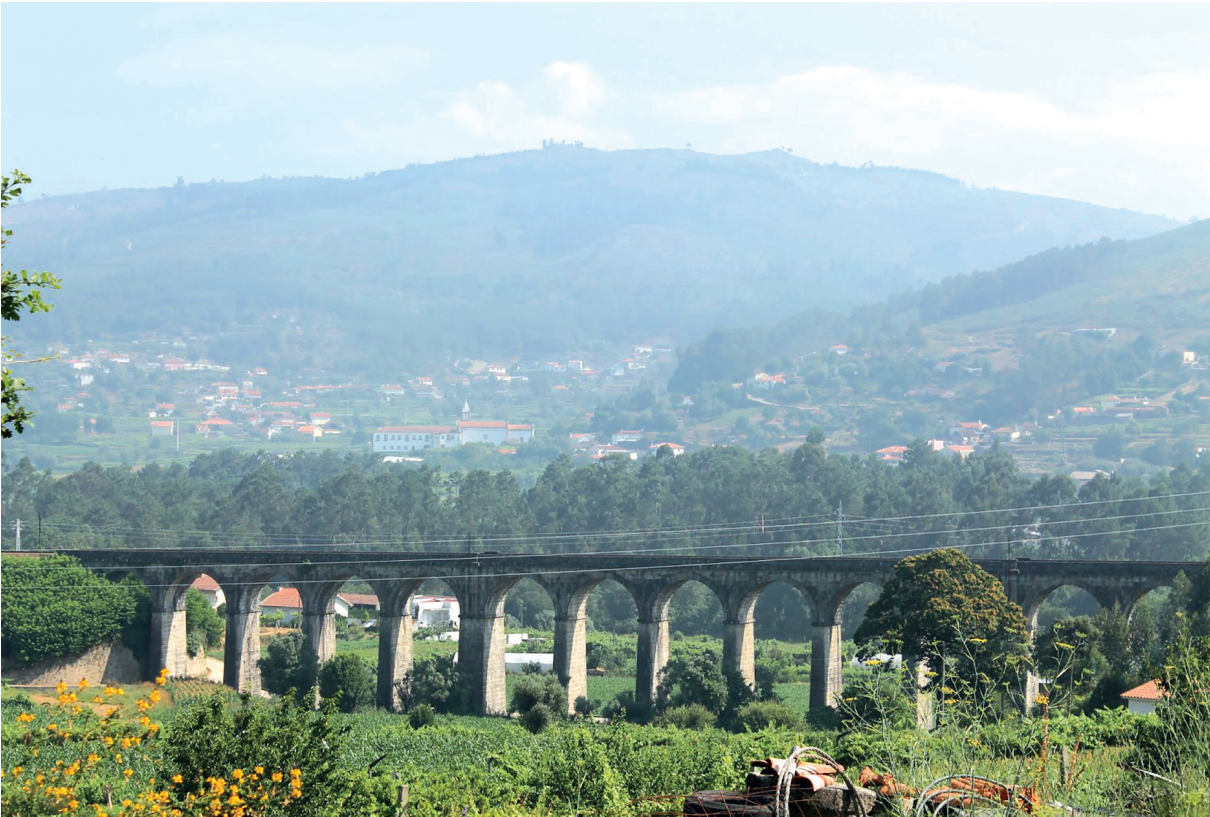
Viaduto ferroviário, denominado localmente por “Ponte Seca” (Durrães)
