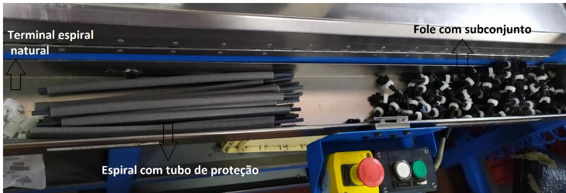
Figura 16 - Posto de injeção do terminal de espiral natural e da montagem de fole com o subconjunto
