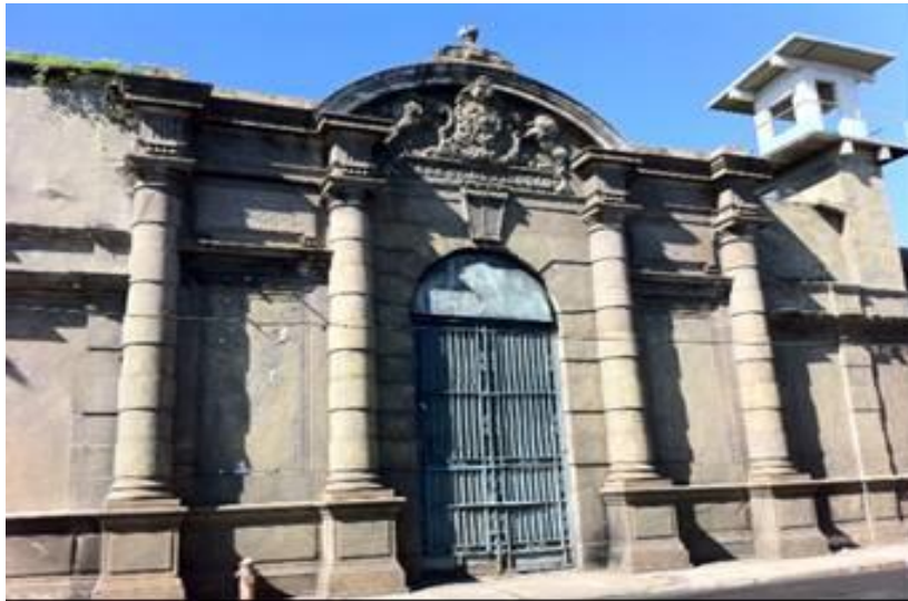
Figura 32 Pórtico tombado da antiga Casa de Correção. Foto: Marilene Rosa Nogueira da Silva, 2012.
