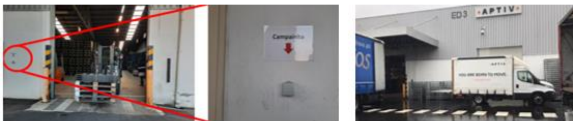
Figura 86- Colocação de campainha junto ao cais de descargas e nova porta de acesso a peões
