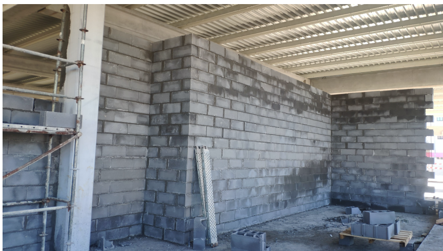
Figura 29 - Parede de alvenaria de bloco de betão
