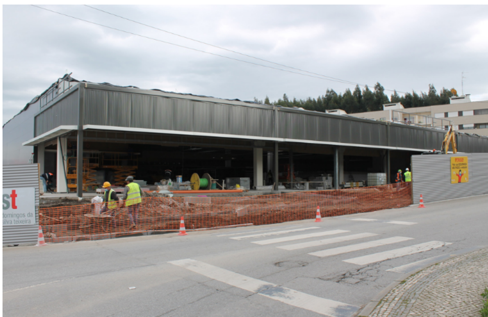
Figura 19 – Imagem da obra I
