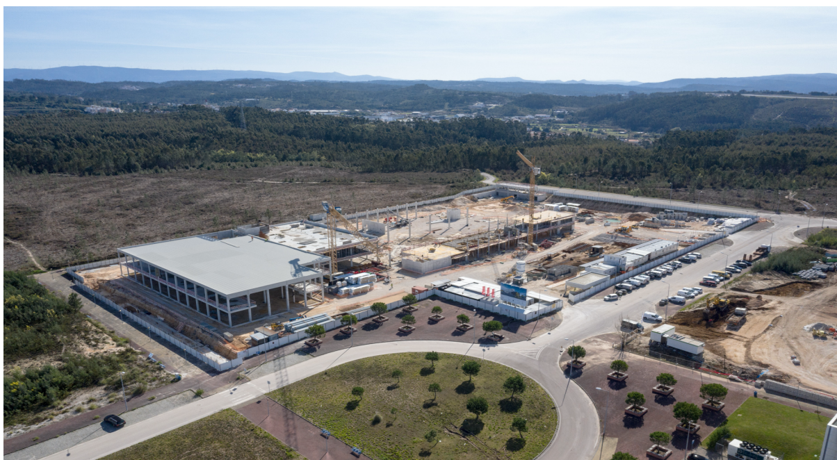
Figura 20 – Imagem da obra II
