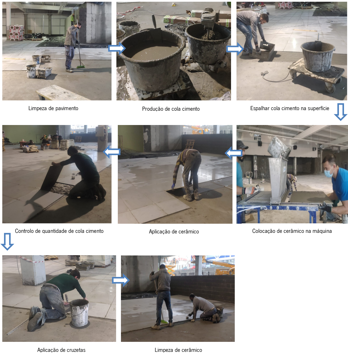
Figura 36 - Processo de aplicação de pavimentos de cerâmicos
