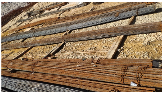
Figura 40 - Armazenamento de atados ferro em obra
