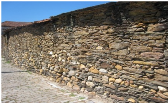
Fig. 4.23. Blocos de quartzo e quartzíticos frequentemente utilizados como material de construção pela sua consistência face ao xisto.
