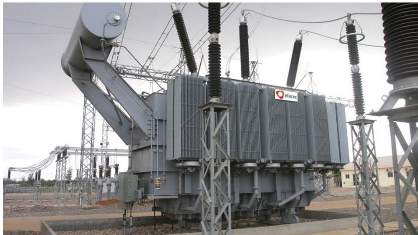
*Figura 9 - Transformador do tipo Core
