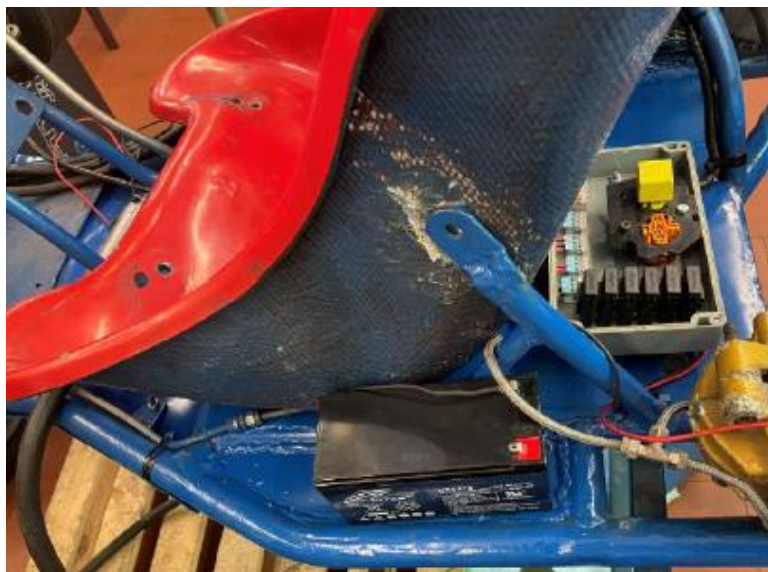
Figura 92. Fotografia com o local da bateria.
