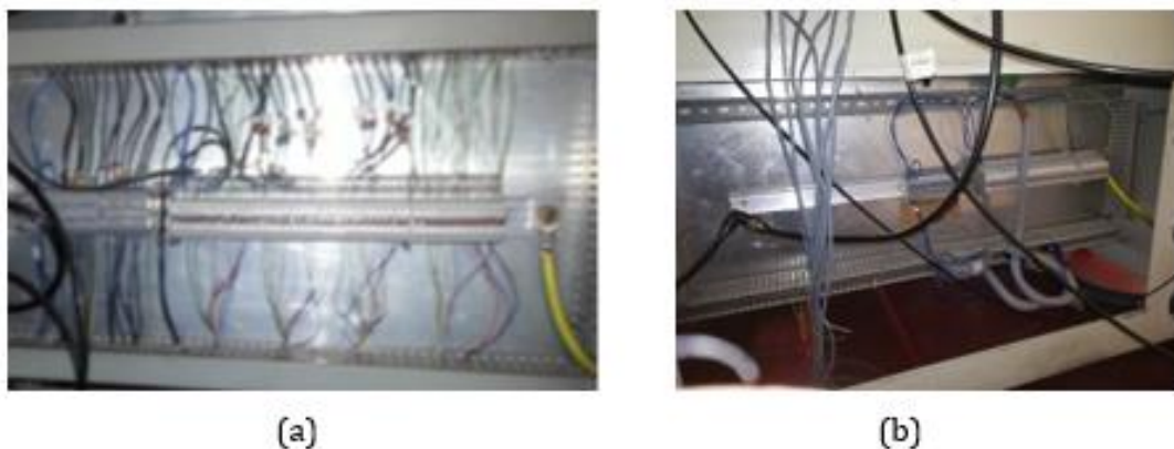
Figura 5.2 - Desconexão de todas as ligações do bloco de terminais eléctricos do centro de maquinagem, (a) antes de desconectar e (b) depois de desconectar.
