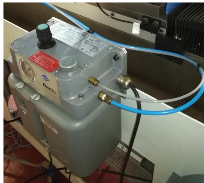
Figura 5.35 - Instalação da unidade de fluido de corte.
