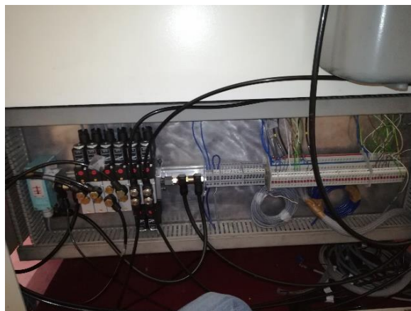
Figura 5.39 - Realização das ligações dos sensores e do sistema pneumático.
