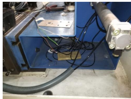
Figura 5.6 - Estado de conservação do interior da estrutura do suporte do trocador ferramentas.
