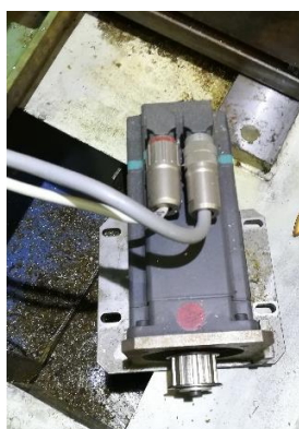
Figura 5.13 - Desmontagem do servomotor do eixo B.
