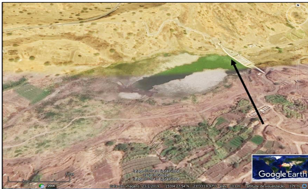
Figura 44- Barragem de Poilão e da respetiva albufeira (Imagem aérea, obtida através do Google™ Earth, com indicação do muro, seta preta)
