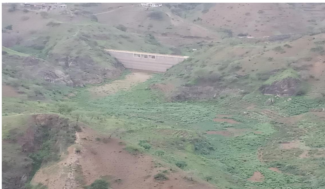
Figura 49 - Estado atual da barragem de Faveta
