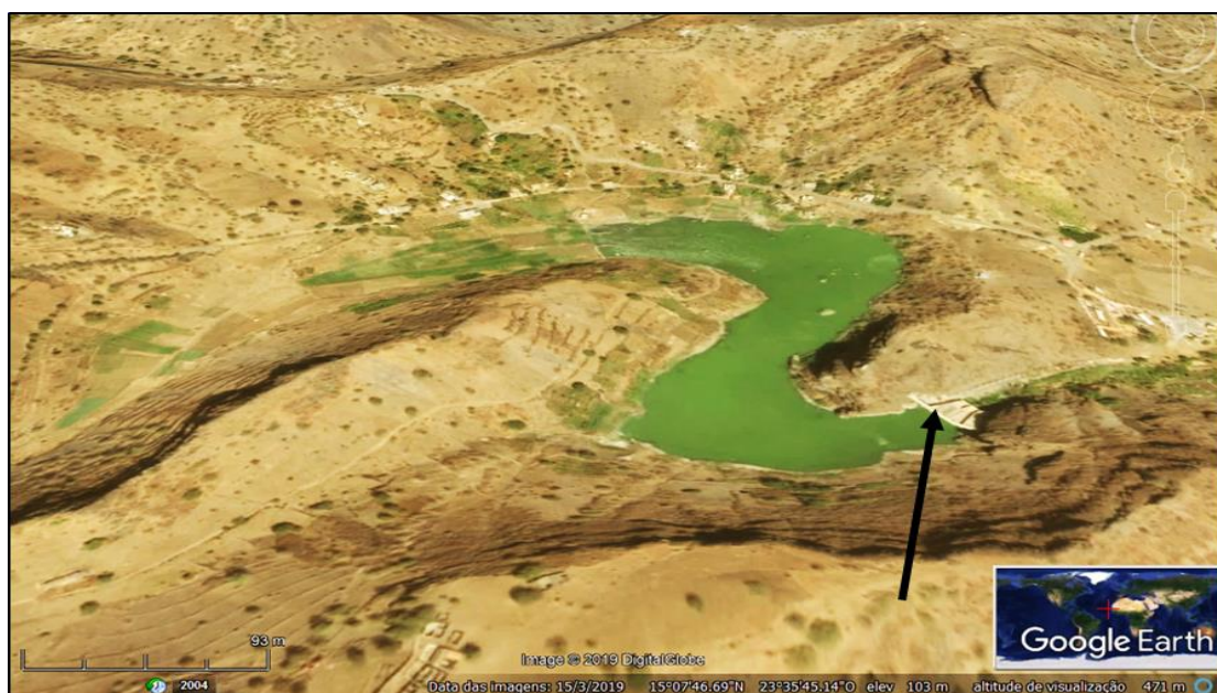
Figura 46- Barragem de Figueira Gorda (Imagem aérea, obtida através do Google™ Earth, com a localização, seta preta).
