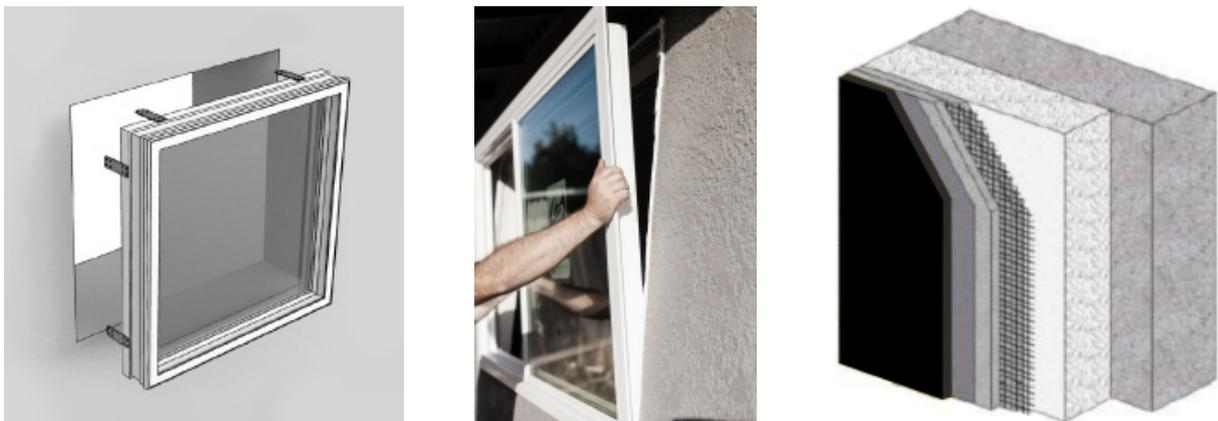
Figura 6. Instalação de janelas de alto desempenho e composição do sistema ETICS
