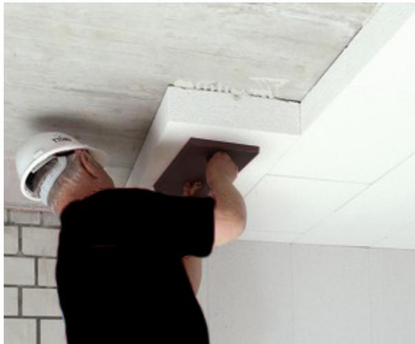
Figura 8. Isolamento térmico pelo interior
