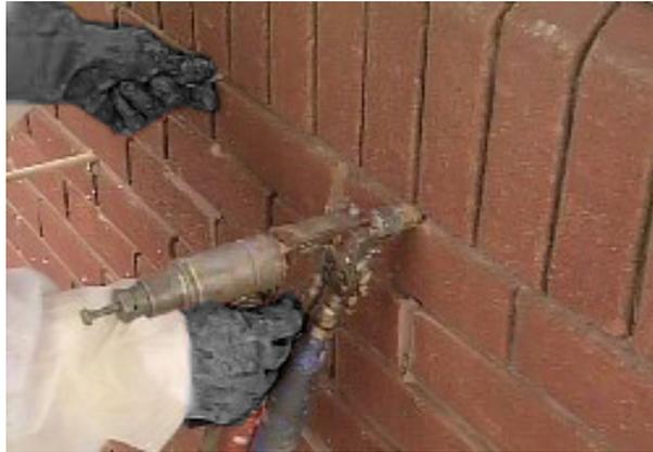
Figura 7. Injecção de isolamento térmico na cavidade de paredes duplas
