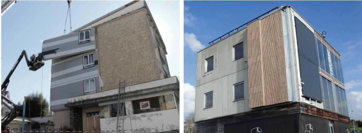
Figura 16. Processo de instalação dos módulos BERTIM
