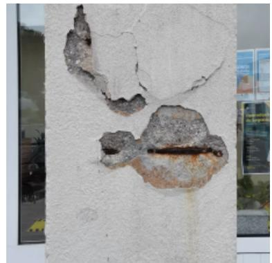
Corrosão da armadura
