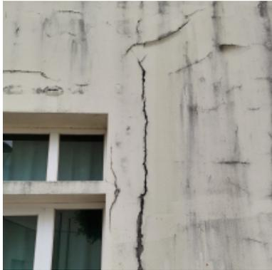
Destacamento e fissuração grave do reboco
