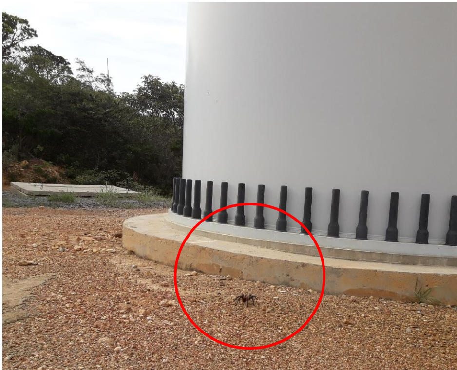
Figura 110: Aracnídeo encontrado na base de um aerogerador em Guanambi. Fonte: Autor (2019).
