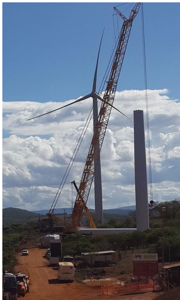
Figura 90: Veículos, materiais e estruturas para a instalação de aerogerador município de Caetité em 2012 / 2013. Fonte: BRAZIL WIND (2013).
