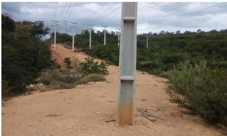
Figura 121: Supressão de vegetação em área de rede elétrica de média tensão. Fonte: Autor (2020).
