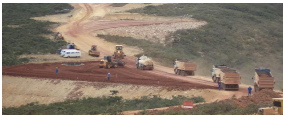
Figura 102: Emissões de poeira e gases de combustão na construção de Parque Eólico, no município de Caetité, em 2014. Fonte: Goetze Lobato Engenharia S.A., disponível em: https://www.gel-eng.com.br/ , acesso em novembro de 2020.
