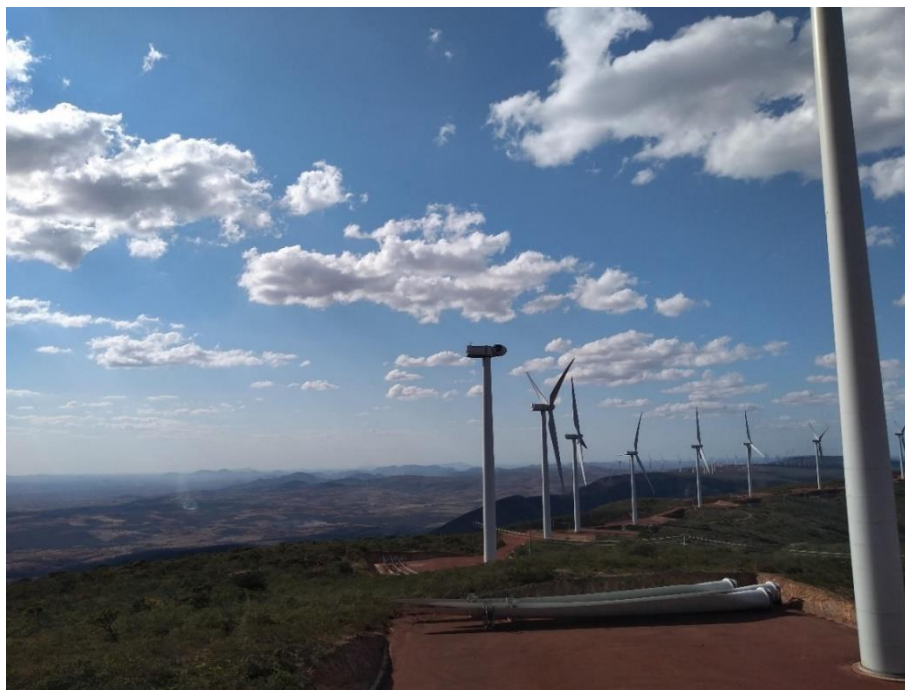
Figura 105: Parque Eólico em implantação em área de topo de morro. Fonte: Autor (2019).
