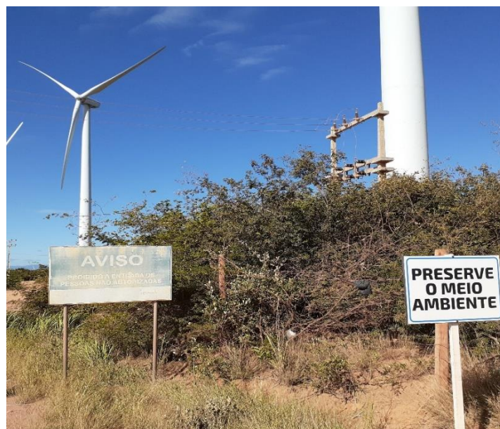
Figura 130: Sinalização de 'preserve o meio ambiente' em Parque Eólico em Guanambi. Fonte: autor (2021).
