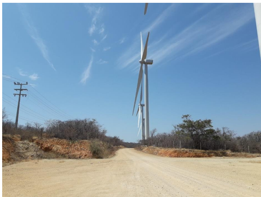
Figura 107: Abertura e manutenção de acesso para o Parque Eólico. Fonte: Autor (2019).
