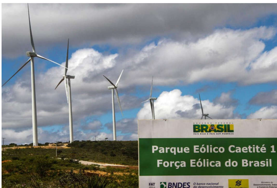
Figura 94: Operação de Parque Eólico em Caetité como atividade econômica. Fonte: Radio portal sudoeste, disponível em: https://www.radioportalsudoeste.com.br/noticias/3771-novos-parques-eolicos-em-caetite-e-tanque-novo-devem-gerar-1-mil-empregos , Acesso em dezembro de 2020.
