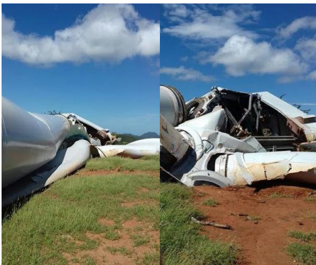
Figura 114: Aerogerador que tombou em Igaporã em 2016. Fonte: Mídia Bahia (2016), disponível em https://midiabahia.com.br/torre-do-parque-eolico-desaba-no-municipio-de-igapora/ acesso em setembro de 2020.
