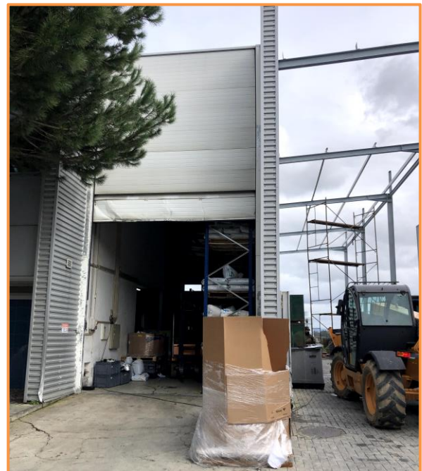
Figura 44- Obras de expansão do edifício de produção
