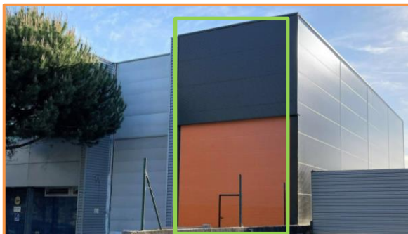
Figura 43- Expansão do edifício de produção da empresa
