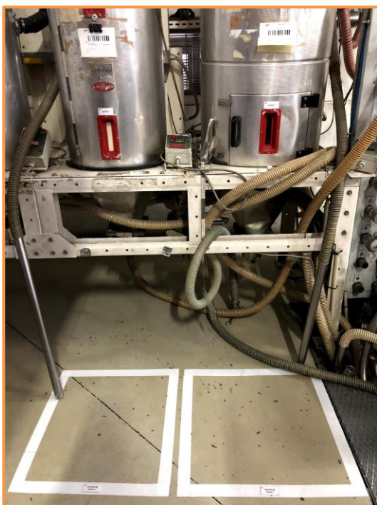
Figura 24- Delimitação da zona dos contentores da MP das estufas
