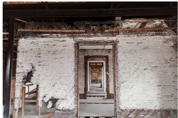
Figura 11: Parede divisória de tabique;
