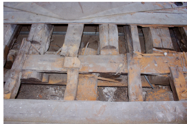
Figura 13: Estrutura em Madeira de castanho;
