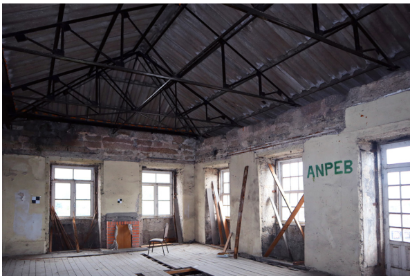
Figura 10: Parede de Alvenaria de Pedra;
