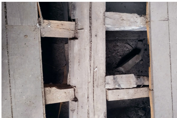
Figura 14: Pavimento em madeira de pinho bravo;
