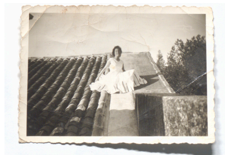
Figura 56 : Pormenor da Cobertura da Casa Martins Sarmento;
