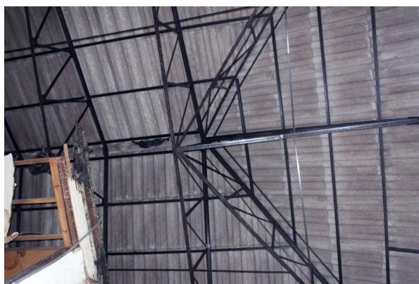
Figura 17: Cobertura provisória realizada com uma estrutura em aço;
