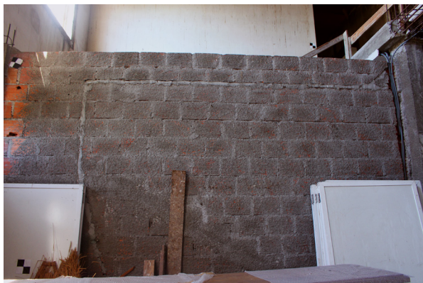
Figura 16: Parede de Alvenaria de Tijolo;
