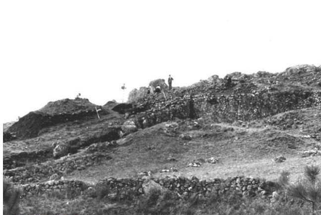
Figura 2 : Ruínas de Sabroso
