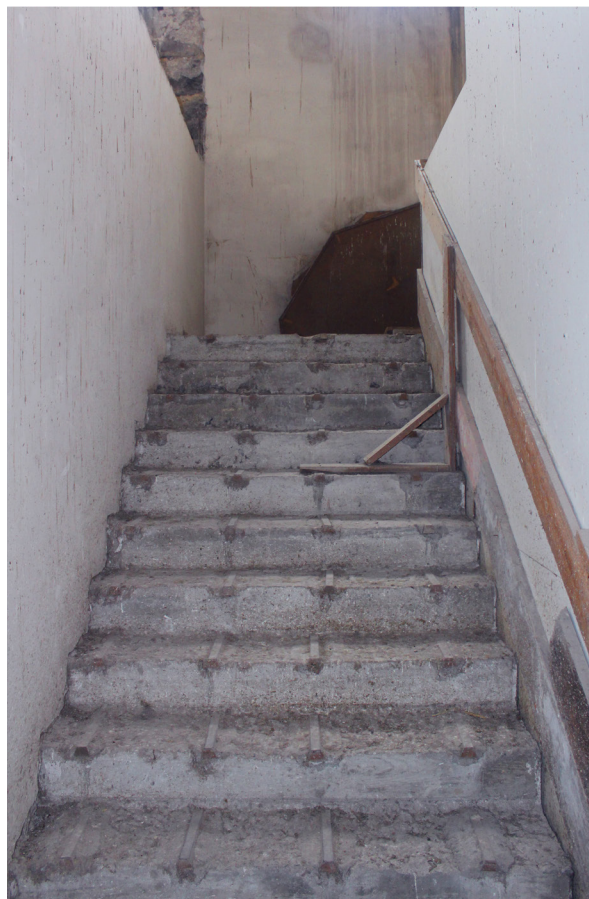
Figura 18: Escadas em Betão;
