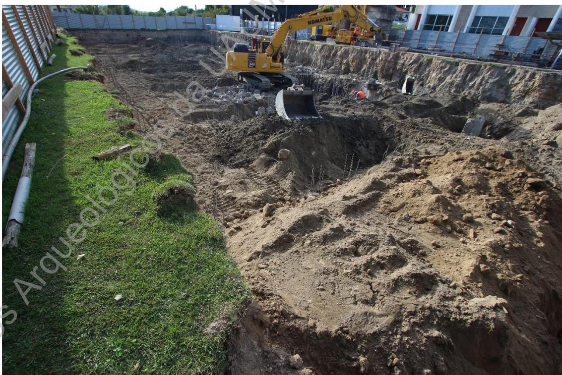
**Foto 8 (IMG\_9663)** – Perspetiva geral da área após conclusão do trabalho de abertura das valas para sapatas.
