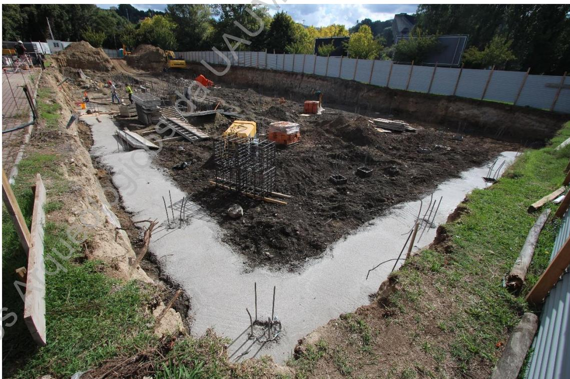
**Foto 14 (IMG\_9691)** – Aspeto geral da área com aplicação de betão nas sapatas.
