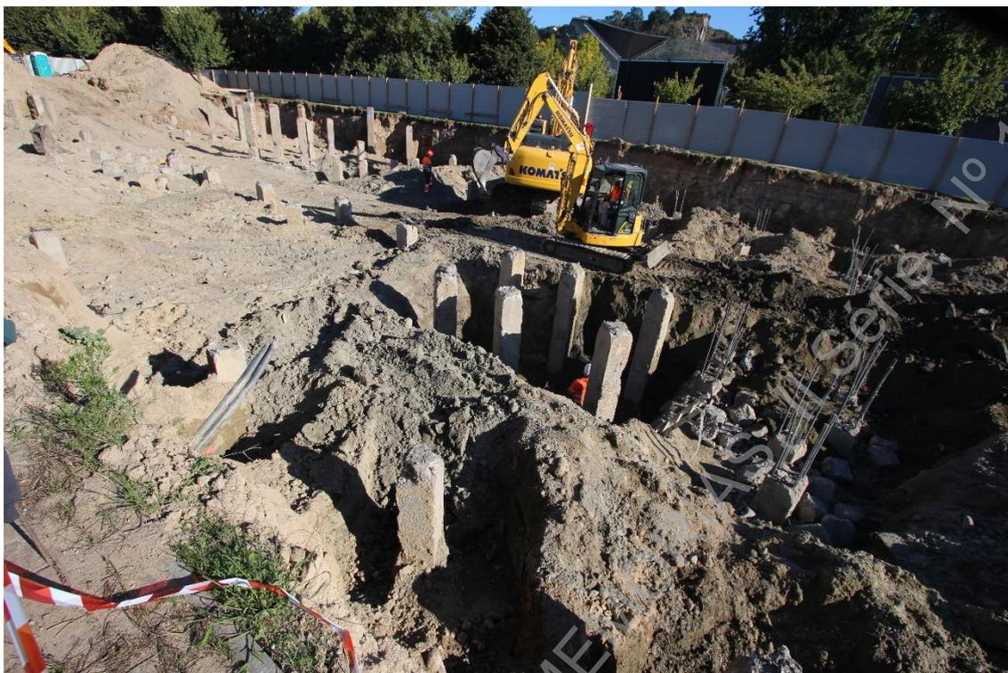
**Foto 7 (IMG\_9600)** – Acompanhamento da abertura de valas para sapatas e caixa de elevador.
