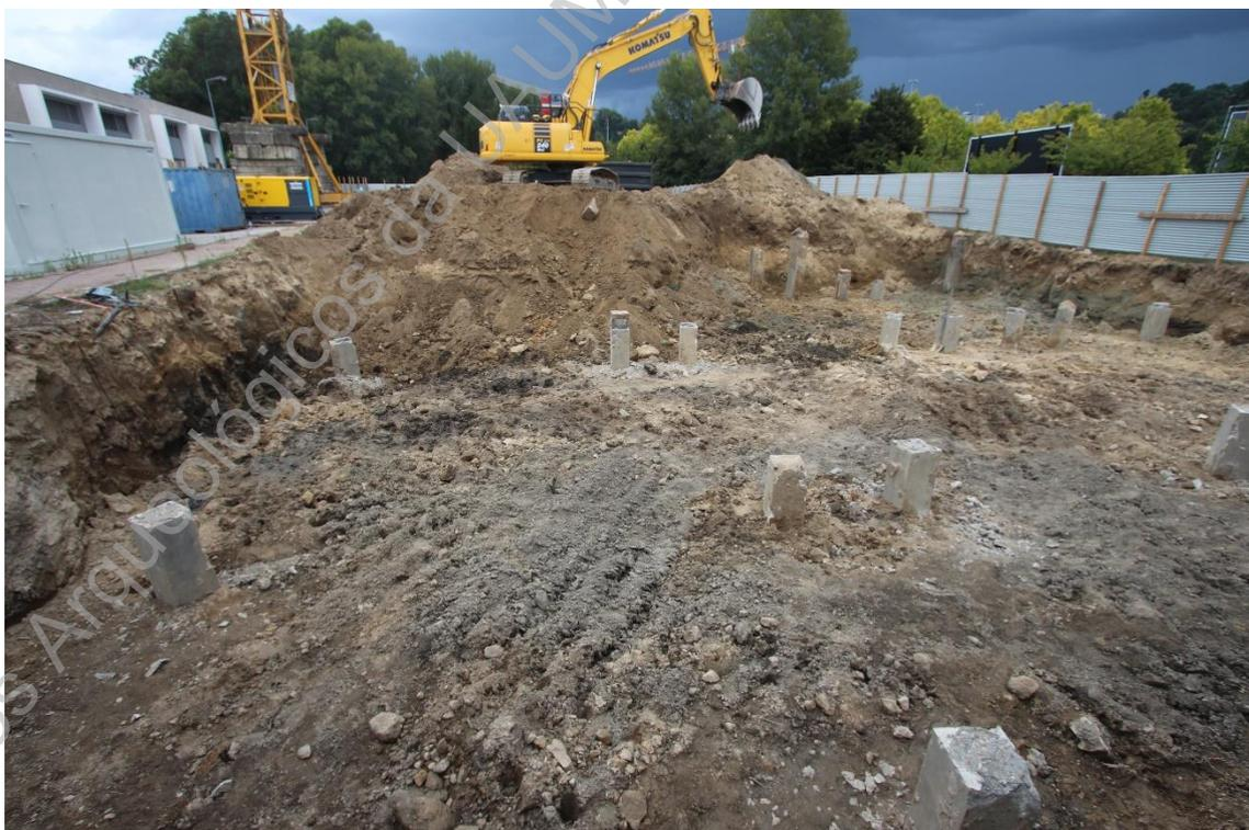
**Foto 4 (IMG\_9098)** – Continuação da decapagem do terreno.
