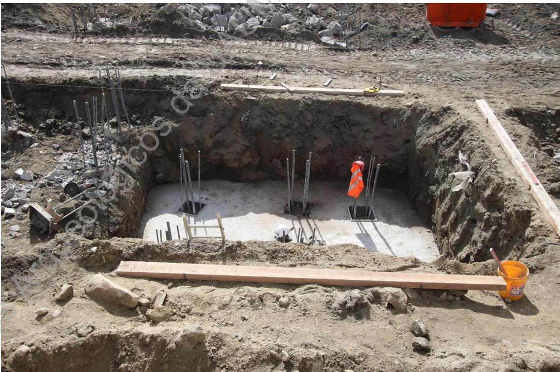
**Foto 16 (IMG\_9696)** – Pormenor da colocação de betão na caixa de elevador.
