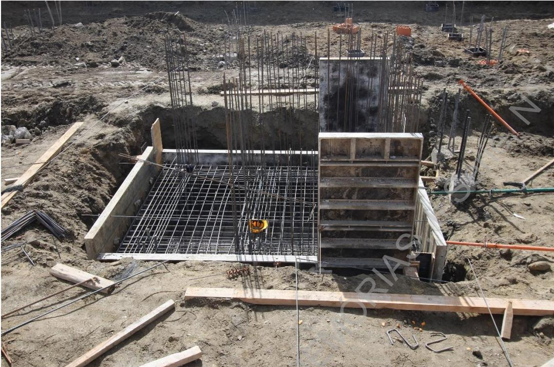
**Foto 15 (IMG\_9695)** – Pormenor da colocação de ferro armado na caixa de elevador.
