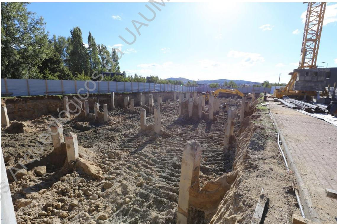
**Foto 6 (IMG\_5046)** – Perspetiva geral da área após conclusão do trabalho de decapagem.
