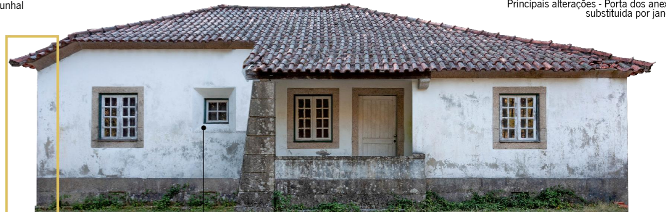
Introdução de uma janela quadrada com capialço
