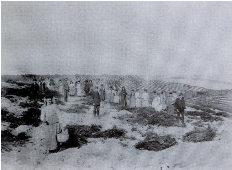
Fig.6. Sementeiras da Mata do Urso. Figueira da foz. Espalhamento do Mato sobre os regos nas dunas, (1908-1909)
