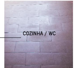
COZINHA / WC Pavimento cerâmico
