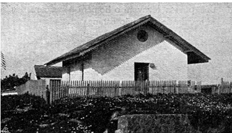
Fig.35. Tipologia das casas de guarda – Início do Séc. XX
