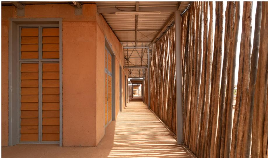
**Ilustração 94** – Construção da cobertura e representação do sistema de arrefecimento.
