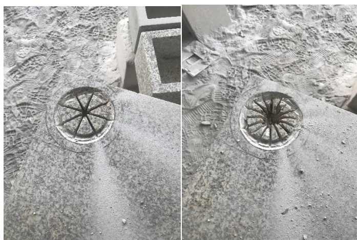
Ilustração 97 - Dividir o círculo em 8 e 16 partes
