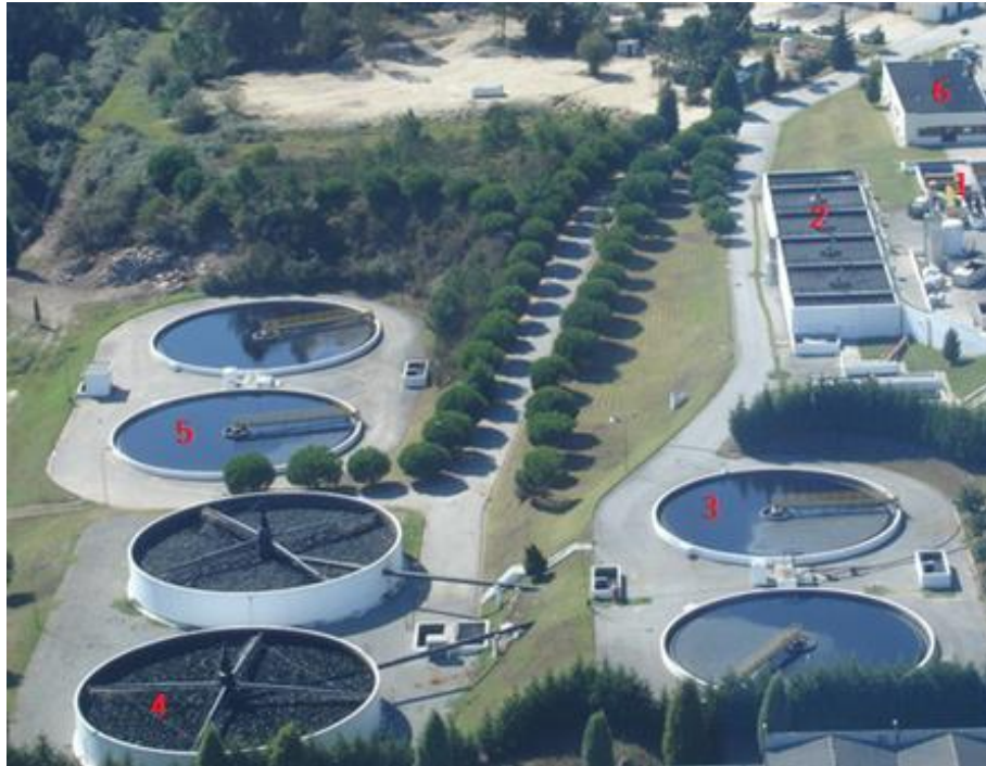
Figura 16: Vista aérea da ETAR de Barcelos. 1 - Gradagem e desarenamento/desengorduramento; 2 - Tanque de lamas ativadas; 3 - Decantadores primários; 4 - Leitos percoladores; 5 - Decantadores secundários; 6 - Laboratório e gabinetes.
