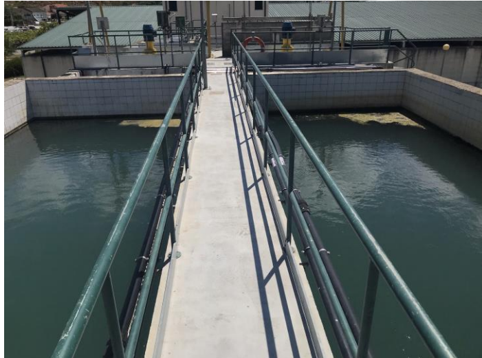
Figura 6. Tanque de contacto com dióxido de carbono.
