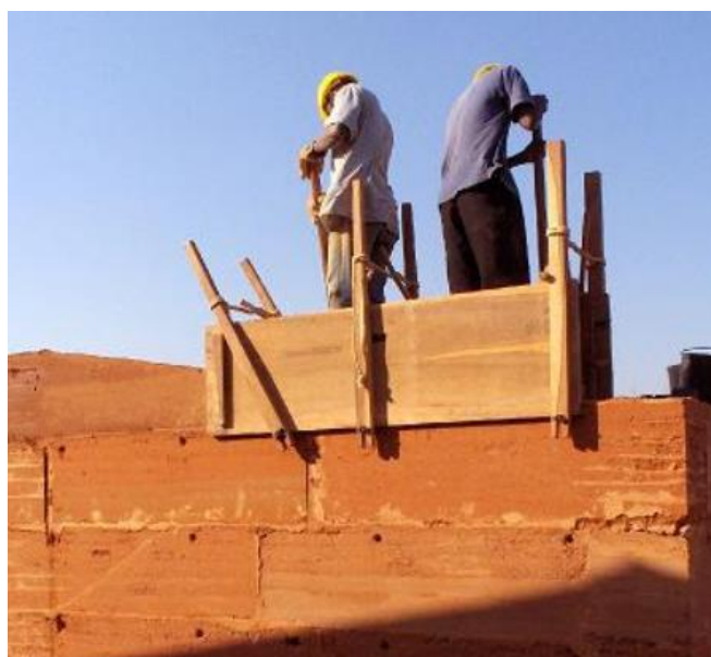
Figura 2.6 - Construção de parede em taipa de compactação manual, e taipal de madeira. (Foto do Arq. Miguel Mendes)
