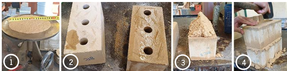
Figura 4.32 - Argamassas de assentamento em BTC (1- teste de espalhamento; 2- ranhuras e hidratação do BTC; 3- aplicação da argamassa, e 4- união dos BTCs)
