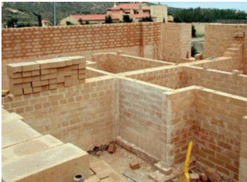
Figura 2.16 - Construção de alvenaria com uso de BTC, Alentejo (Fonte: Torgal & Jalali, 2010)
