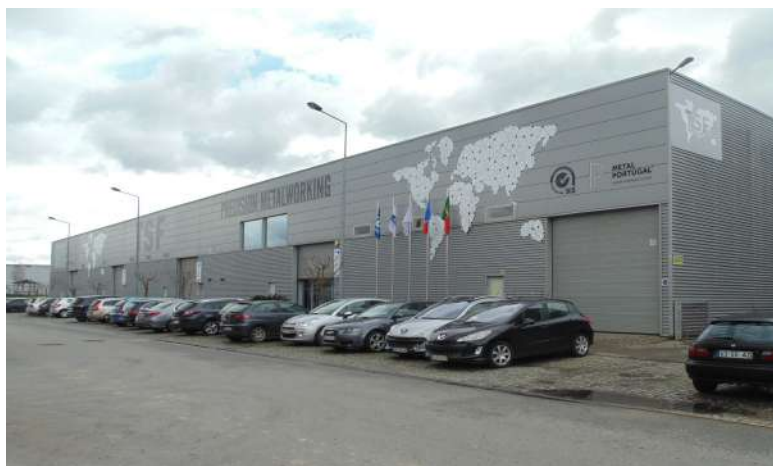
Figura 8. Instalações da empresa TSF.
