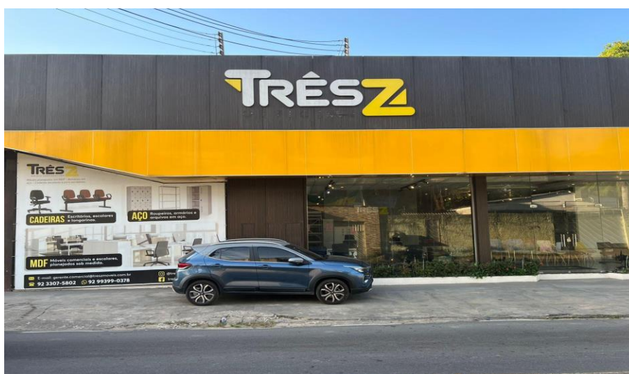
Figura 4 - Fachada da empresa
