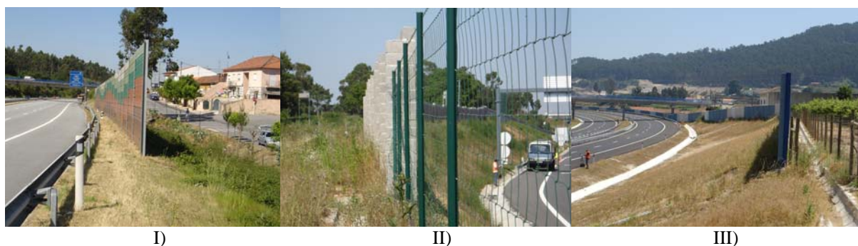
Figura 4 – Barreira em: I) metal perfurado; II) alvenaria; III) painéis de betão pré-fabricados
