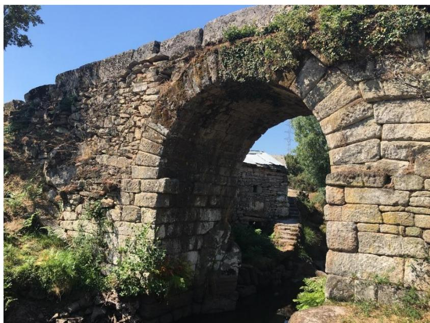
Figura 124 - Pormenor do aparelho de construção da base, em contraste com a zona superior.
