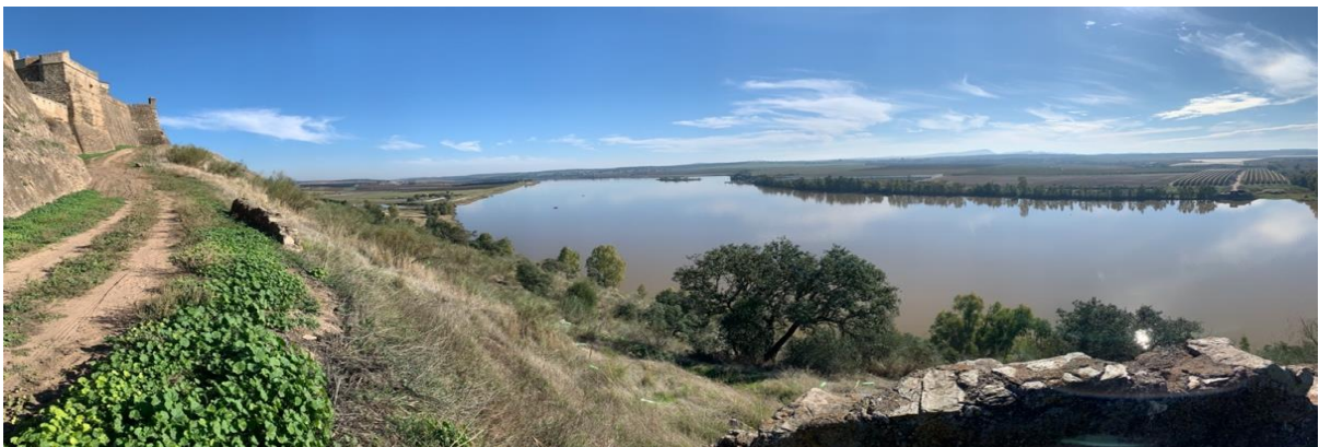
Figura 52. Degrau entre a plataforma em que assenta a fortificação da Juromenha (esquerda) e a superfície aluvionar do rio Guadiana.
