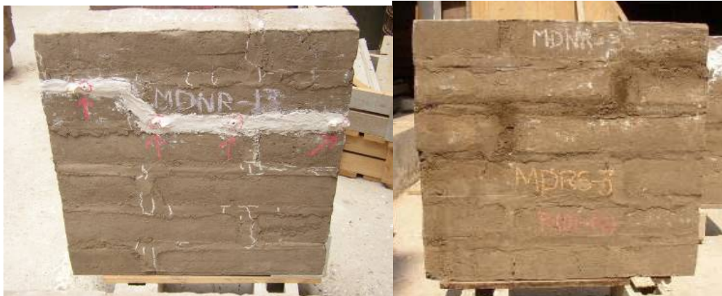
Figura 1 – Injecção de um provete de Adobe (cortesia de M. Blondet, PUCP, Peru)
