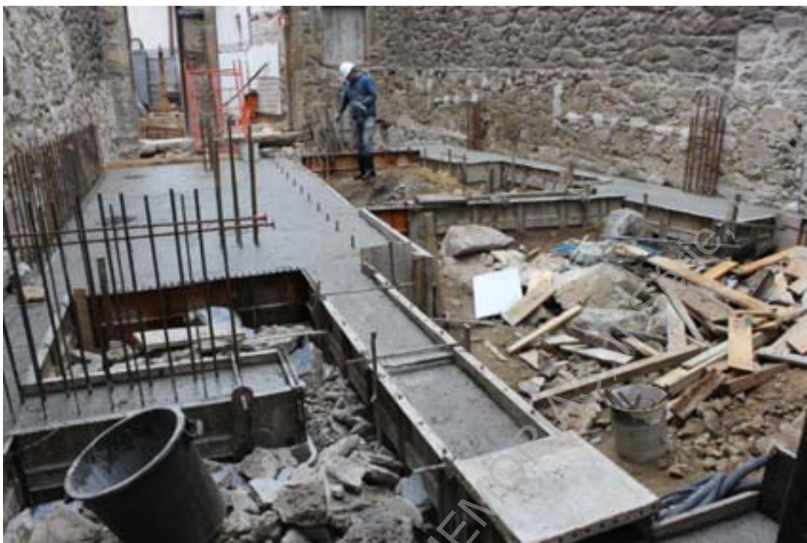
Foto 62 (IMG_0162) – Perspetiva geral da betonagem de sapatas.
