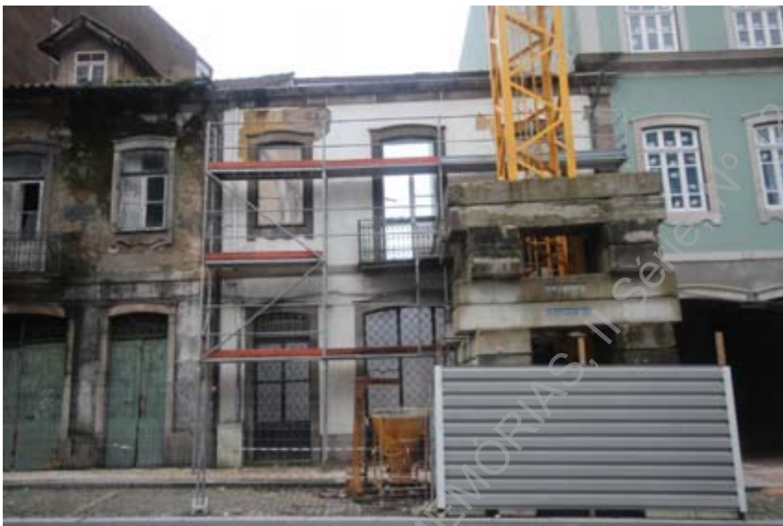
Foto 1 (IMG_2346) – Fachada do edifício localizado na rua do Raio n.ºs 327-333.
