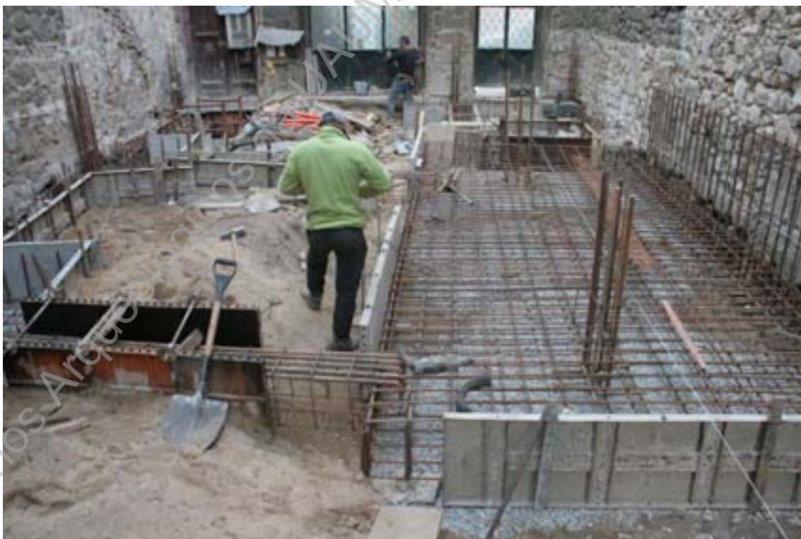
Foto 61 (IMG_0774) – Colocação de estruturas em ferro armado.
