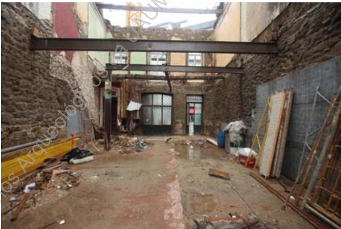
Foto 2 (IMG_2381) – Aspeto geral da área a intervir após trabalhos de demolição.
