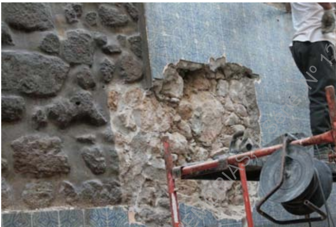
Foto 7 (IMG_0718) – Acompanhamento da remoção dos azulejos.
