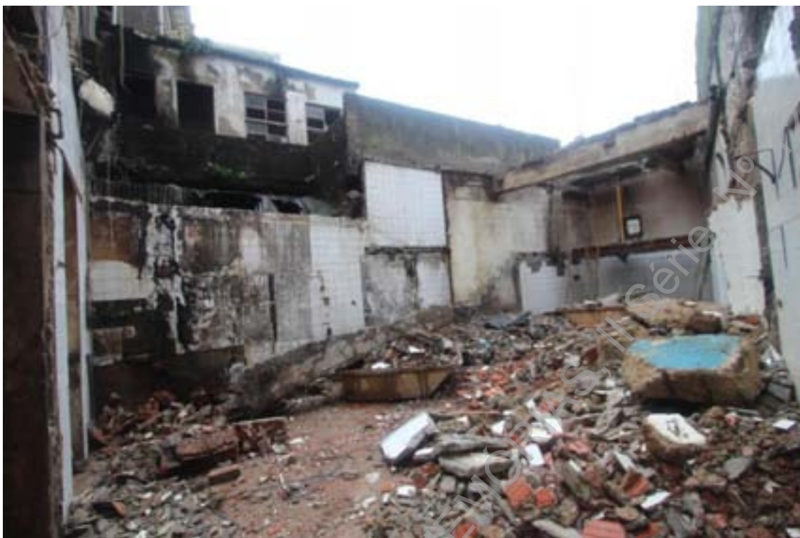
Foto 3 (IMG_2329) – Vista geral da área de traseiras do edifício após demolições.
