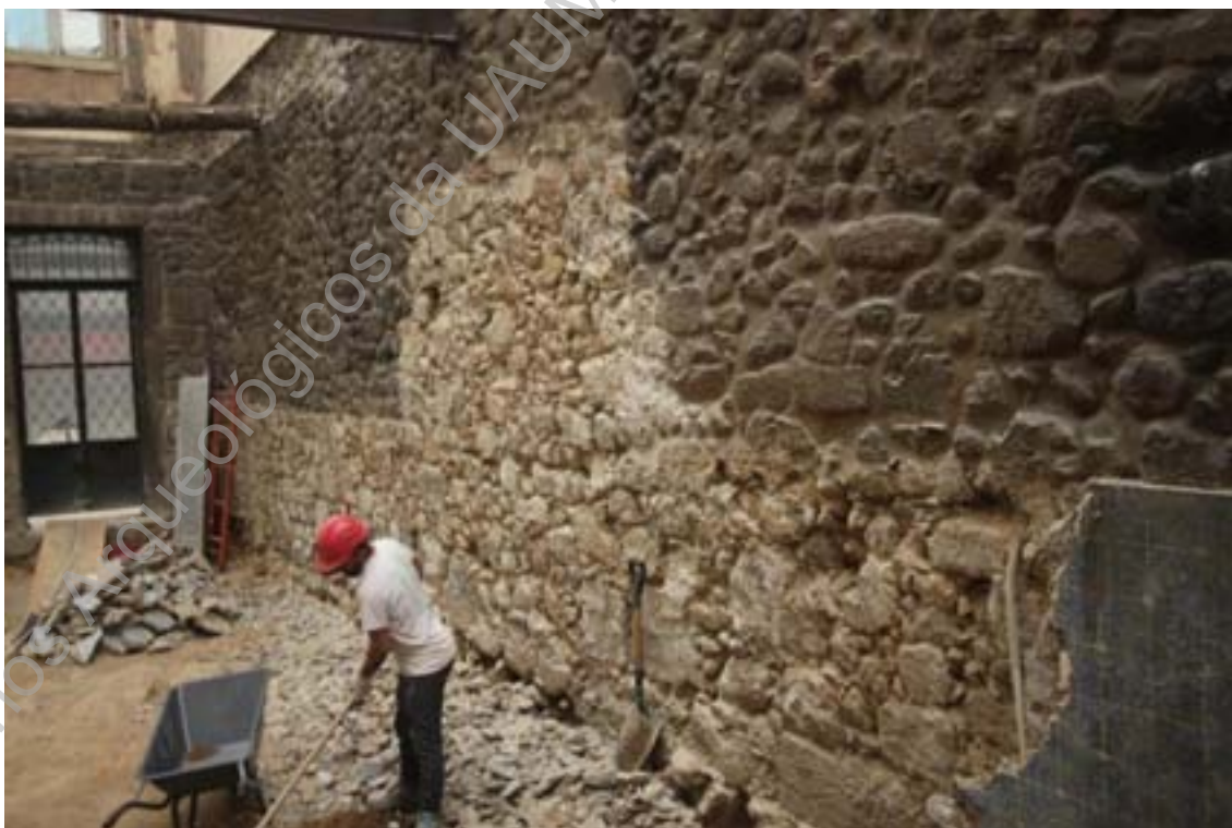
Foto 8 (IMG_4418) – Conclusão do trabalho de remoção dos azulejos.
