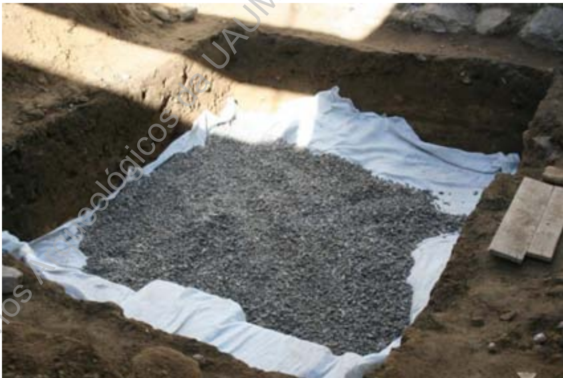
Foto 57 (IMG_9794) – Acompanhamento da colocação de manta geotêxtil e brita na sondagem 1.
