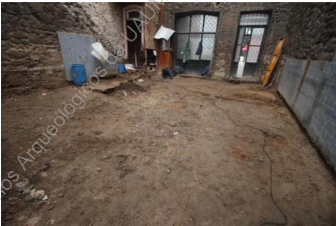
Foto 6 (IMG_2781) – Aspeto geral da conclusão da remoção do piso em cimento.
