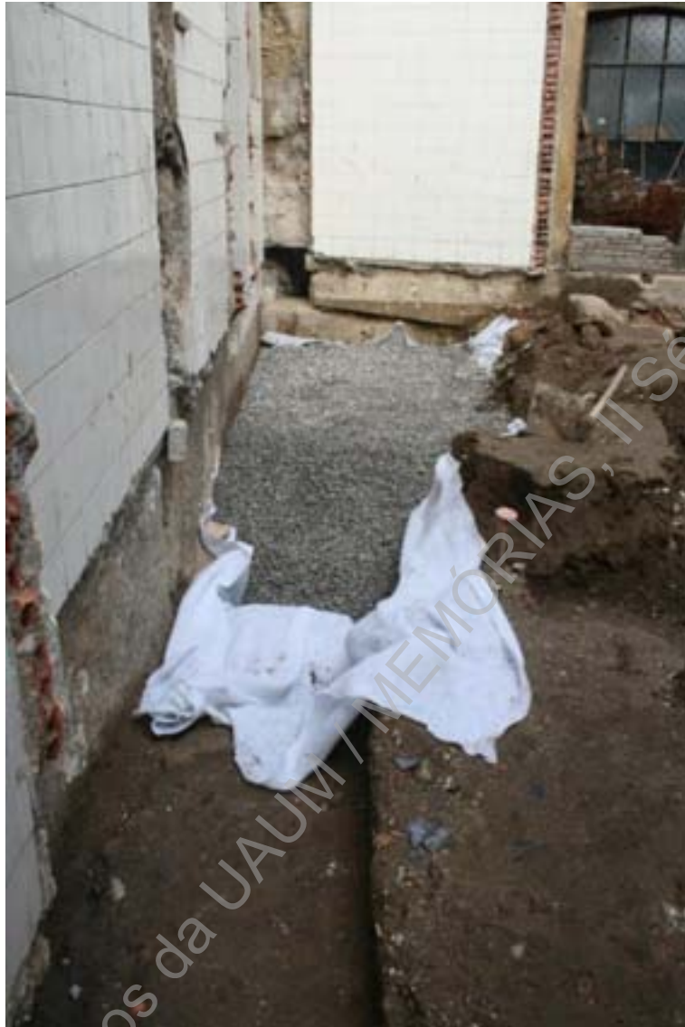
Foto 59 (IMG_1117) – Acompanhamento da colocação de manta geotêxtil e brita na sondagem 3.
