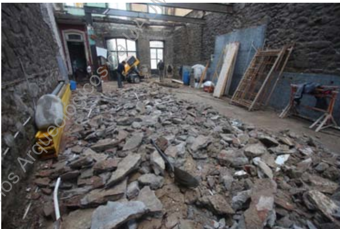
Foto 4 (IMG_2689) – Acompanhamento dos trabalhos de remoção do piso em cimento.
