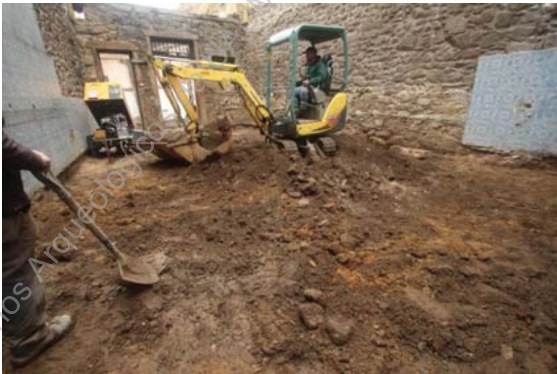
Foto 10 (IMG_2805) – Finalização dos trabalhos de limpeza do terreno.
