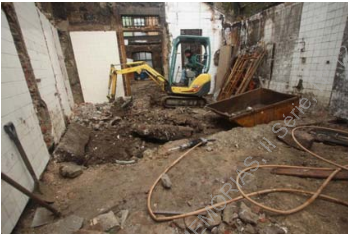
Foto 9 (IMG_2787) – Início dos trabalhos de limpeza do terreno nas traseiras do edifício.
