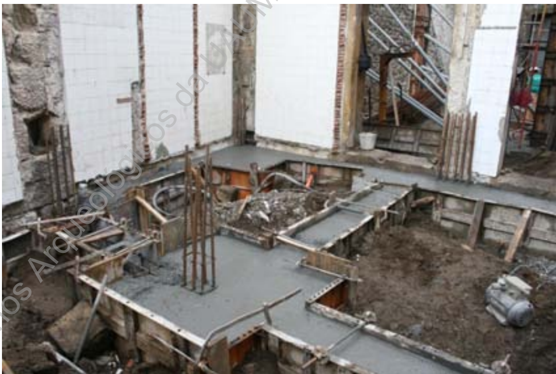
Foto 63 (IMG_1192) – Acompanhamento dos trabalhos de betonagem de sapatas.
