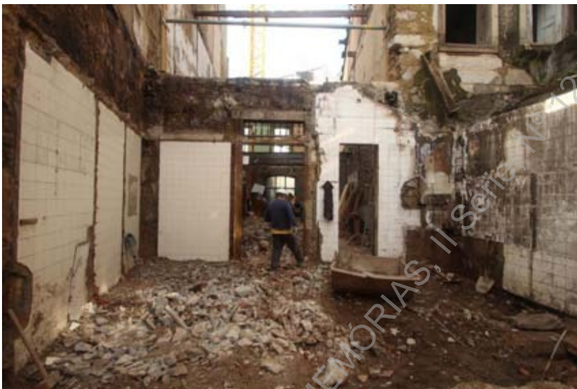
Foto 5 (IMG_2694) – Acompanhamento dos trabalhos de remoção do piso em cimento.
