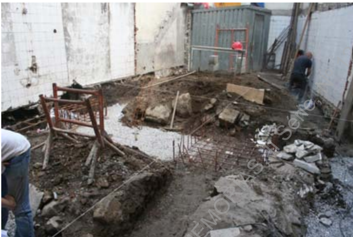
Foto 60 (IMG_1130) – Perspetiva geral da implantação de sapatas.
