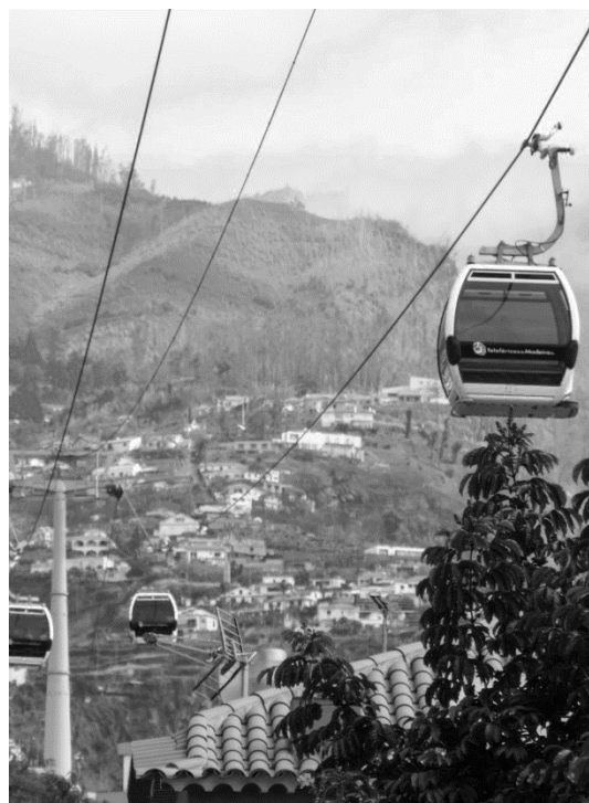
Figura 70- Teleférico Funchal- Monte
