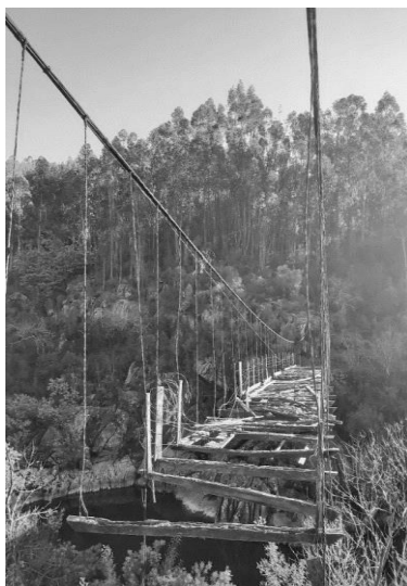
Figura 14- Ponte de Arame Lourido/ Rebordelo
