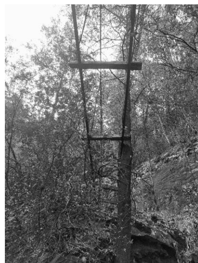
Figura 17 – Ponte de Arame Codeçoso/ Fridão
