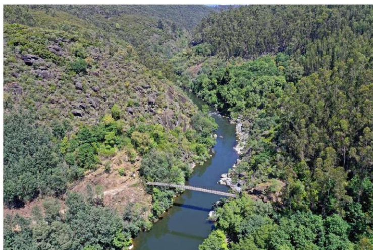
Figura 1.1 - Vista aérea da Ponte de Arame
