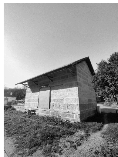
Figura 49 – Edifício de apoio à antiga estação de Codeçoso
