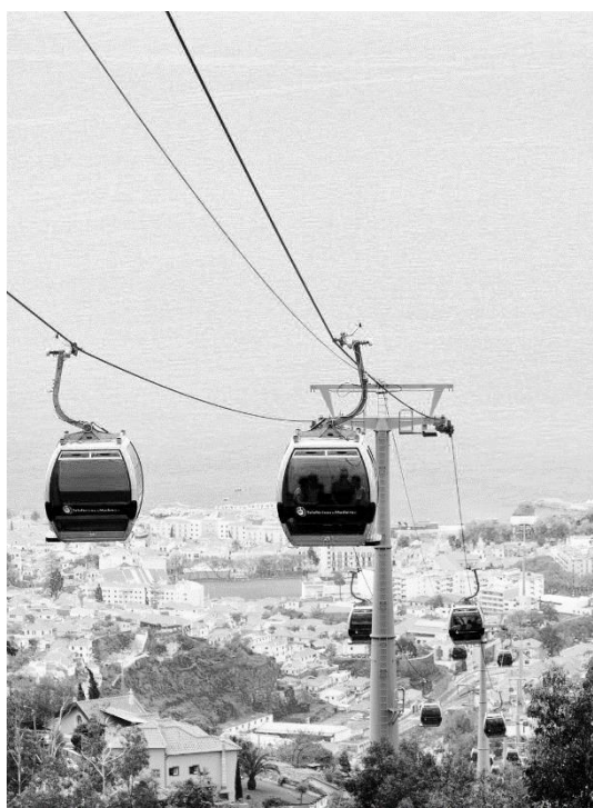
Figura 69- Teleférico Funchal- Monte
