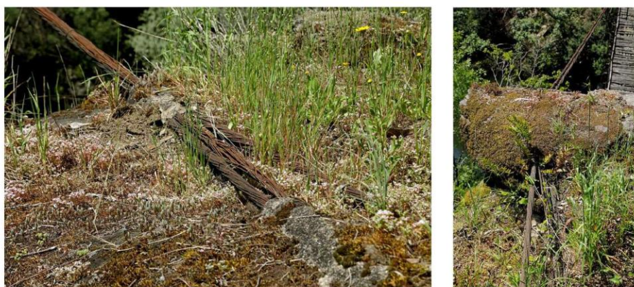
Figura 1.3 - Amarrações dos cabos principais nas margens
