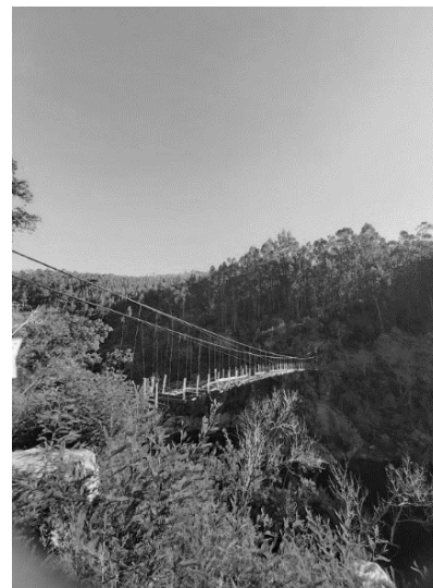
Figura 15- Ponte de Arame Lourido/ Rebordelo
