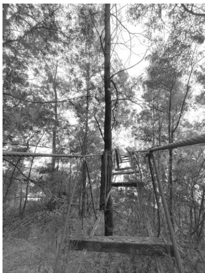
Figura 16 – Ponte de Arame Codeçoso/ Fridão
