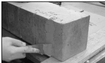
Remoção do adesivo em excesso e execução do acabamento final
