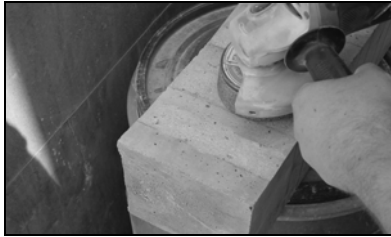
Preparação da superfície: esmerilagem
