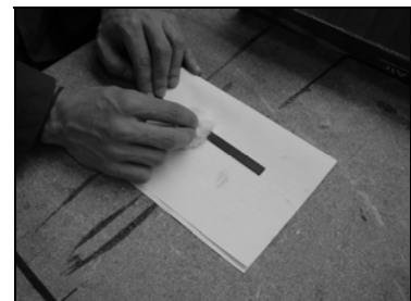
Limpeza do laminado de CFRP
