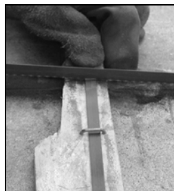
Corte dos laminados no comprimento desejado
