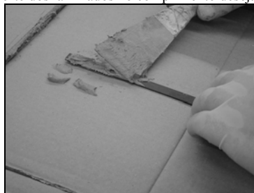
Aplicação do adesivo no laminado
