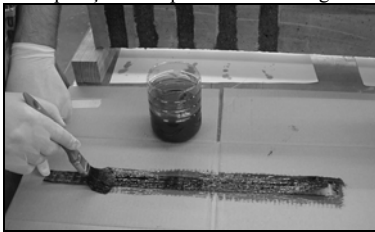
Aplicação de camada de resina na faixa de manta
