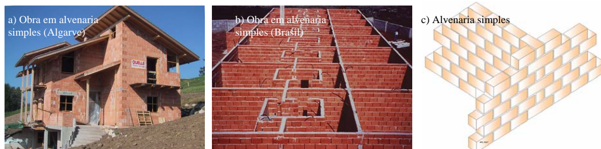
Figura 2 – Exemplo de estruturas de alvenaria simples.
