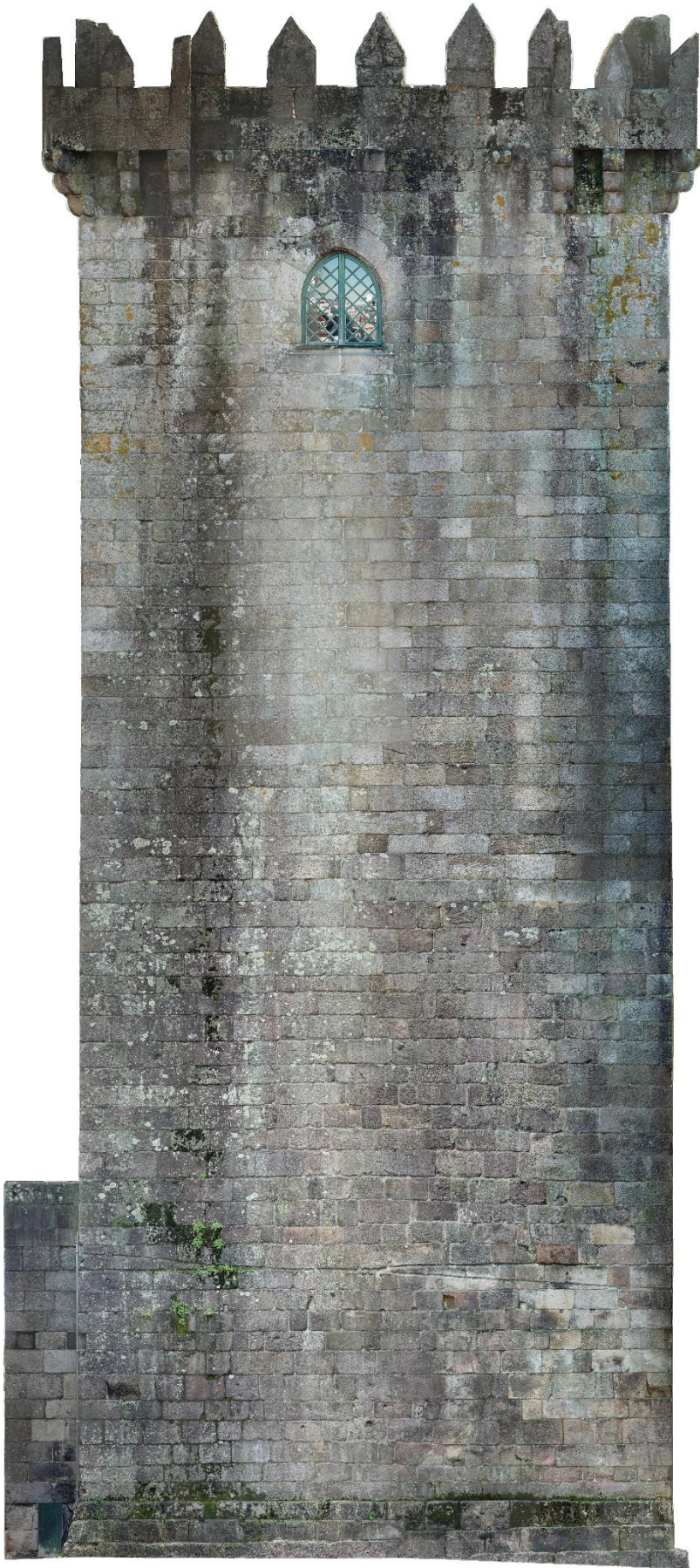
Figura 3- Ortofoto do alçado Norte da Torre de Menagem (UAUM).
