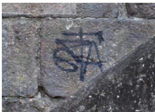
Figura 78- Pormenor da UEM013 da Torre de Menagem
