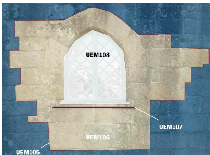
Figura 24- Pormenor das Unidades Estratigráficas Murárias que compõem a janela Norte
