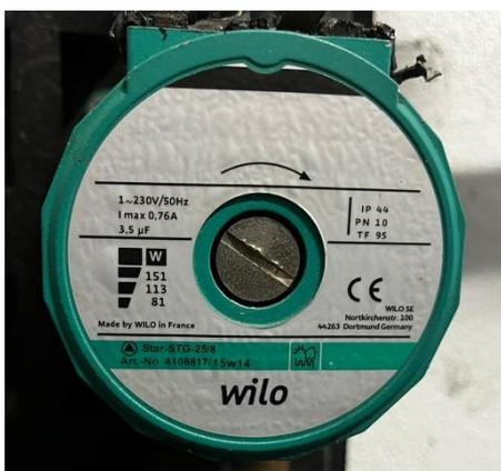
Figura 36 - Bomba de circulação de água para AQS
