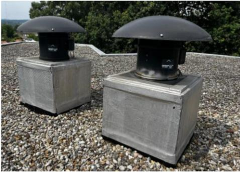
Figura 31 - Ventiladores de extração (VE3 e VE4)
