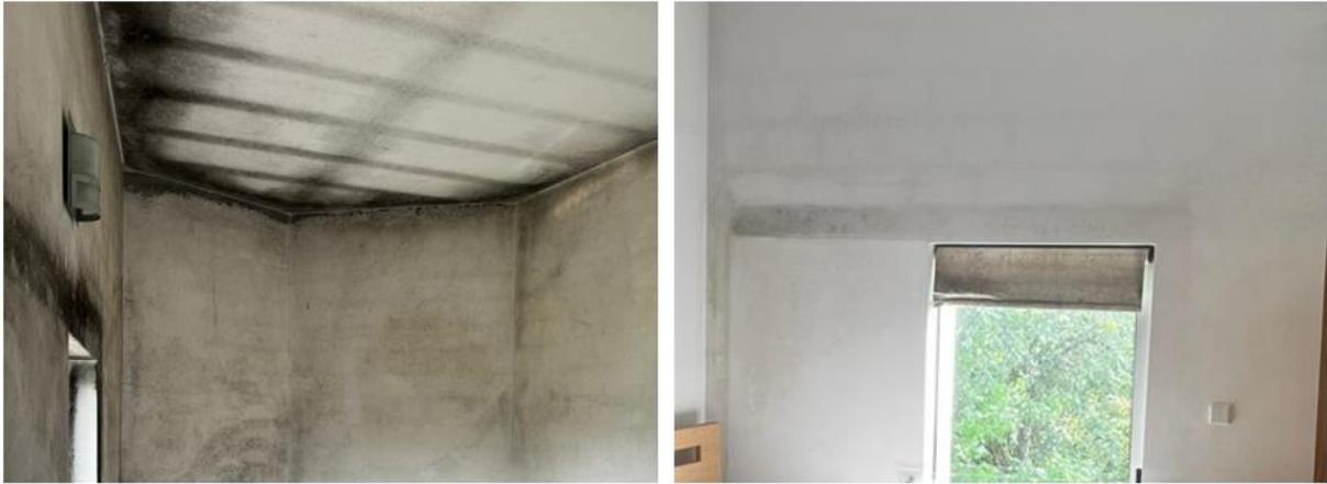
Figura 20 - (a) Manchas no teto da caixa de escadas; (b) Manchas na parede do quarto junto aos envidraçados e manchas nas telas *blackout*; respetivamente (zonas de pontes térmicas planas)
