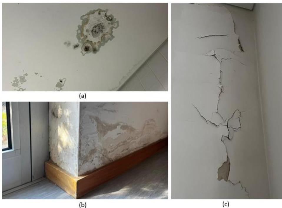
Figura 21 – Exemplo de alguns problemas observados no edifício: (a) Apodrecimento do pladur do teto falso devido à infiltração de água (instalação sanitária 1.09); (b) Descasque da tinta das paredes junto aos envidraçados; (c) Descasque do reboco areado nas paredes interiores junto aos envidraçados
