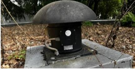
Figura 30 - Ventiladores de extração (VE1, VE2 e VE5)
