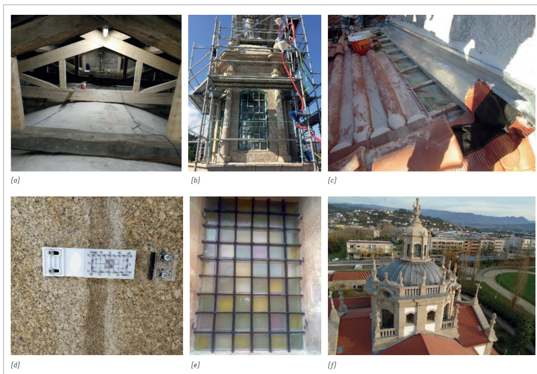
> Figura 4: Pormenores da intervenção: (a) aplicação de nova asna na cobertura na nave, e de novas diagonais e escoras em asnas existentes (madeira lamelada colada); (b) tratamento das cantarias de granito; (c) pormenor da aplicação de novo telhado em telha cerâmica lusa com tela impermeável às águas pluviais e remate em zinco; (d) fissurómetro aplicado em fenda reparada; (e) restauro do vão exterior da igreja; (f) vista do zimbório e coberturas após a intervenção.
