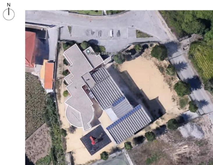
Figura 5 – Vista aérea da localização do edifício escolar em estudo.
