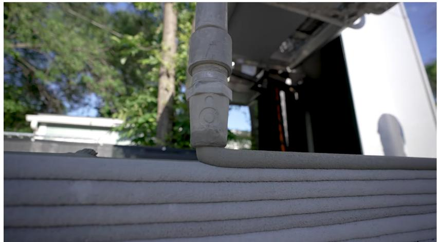
O extrusor usado acima, é um pouco diferente da utilização de um braço robótico, o sistema usado na *House Zero*, é mais semelhante a uma impressora 3D comum de pla com 3 eixos de movimento apenas, o x, y e z. Apenas é necessária a instalação em obra de dois “carris” onde o extrusor se movimentará e, por cima das fundações previamente executadas, a impressão terá lugar.
