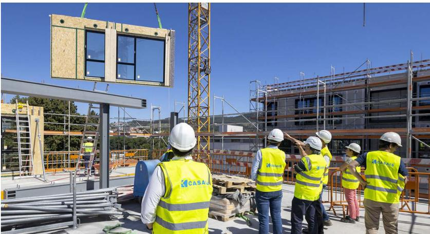
**Figura 3.3.8.** Imagem da instalação de um painel de fachada pré-fabricado no edifício habitacional “The First” produzido pela empresa Casais nas proximidades da Universidade do Minho em Azurém
