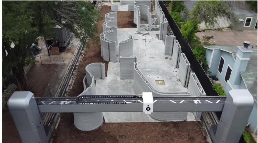
**Figura 3.3.6.** Imagem fotográfica de uma parede da *House Zero* a ser impressa, Icon.
