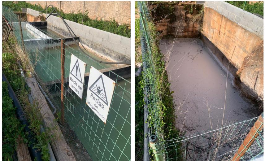
**Figura 2.4.4.** Fotos de silos decantadores onde as lamas se armazenam. Foto à esquerda - Brita-minho. Foto à direita - Grupo Galvão
