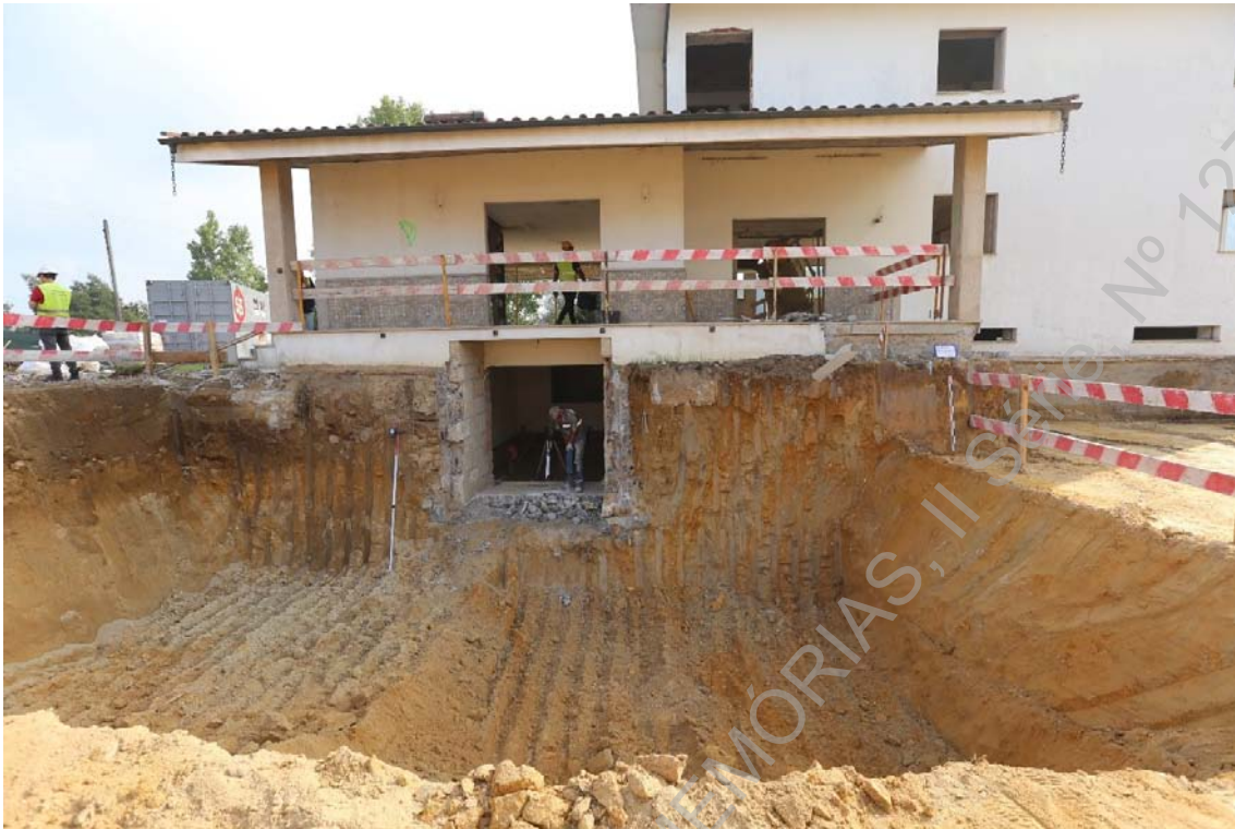
Foto 17 (IMG_2238) –Registro do perfil este da sondagem 2
