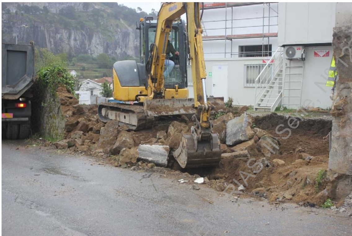
Foto 23 (IMG_6212) –Acompanhamento dos trabalhos de demolição do muro UE061.
