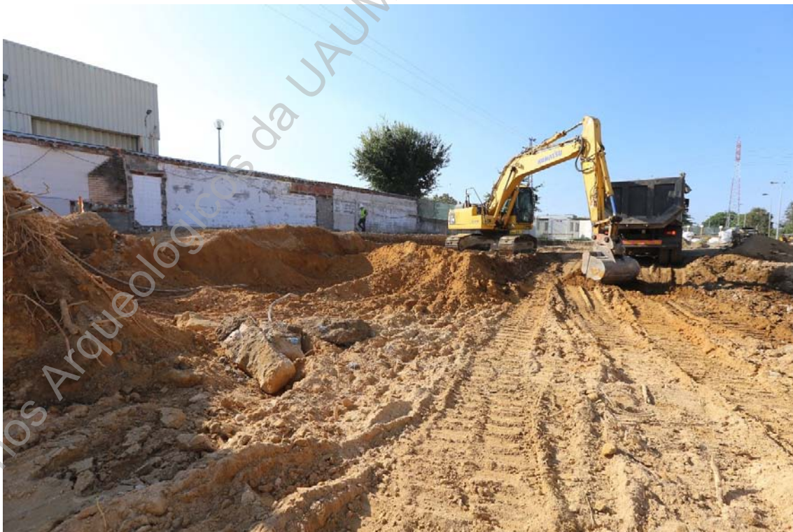
Foto 4 (IMG_2152) – Acompanhamento da decapagem do terreno para implantação das infraestruturas do novo edifício.
