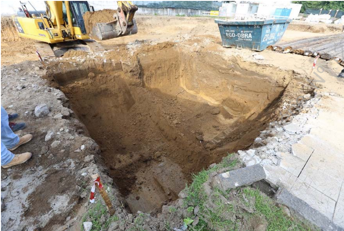
Foto 9 (IMG_2246) – Trabalho de acompanhamento da abertura da sondagem 1.
