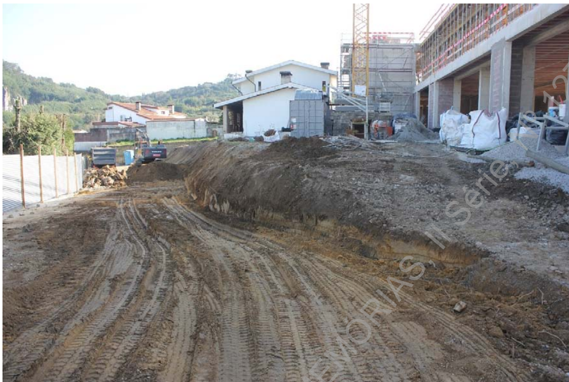
Foto 21 (IMG_5520) –Acompanhamento da decapagem do terreno a poente da antiga habitação.
