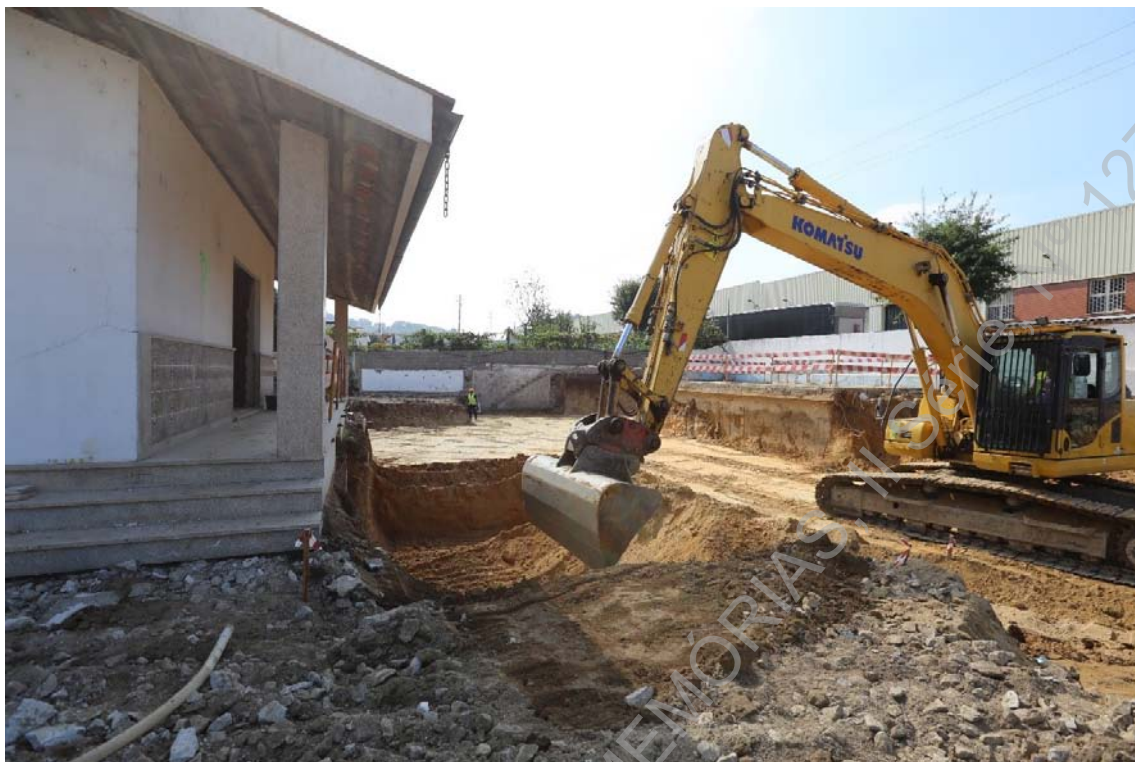
Foto 15 (IMG_2164) – Acompanhamento do desaterro da sondagem 2.
