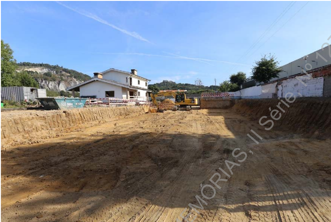
Foto 7 (IMG_2860) – Acompanhamento do desaterro na área noroeste do logradouro.
