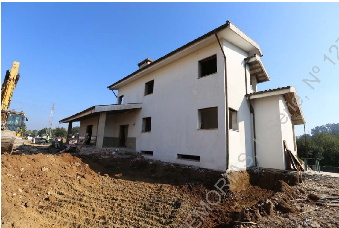
Foto 5 (IMG_2123) – Decapagem de terras junto ao edificado antigo.
