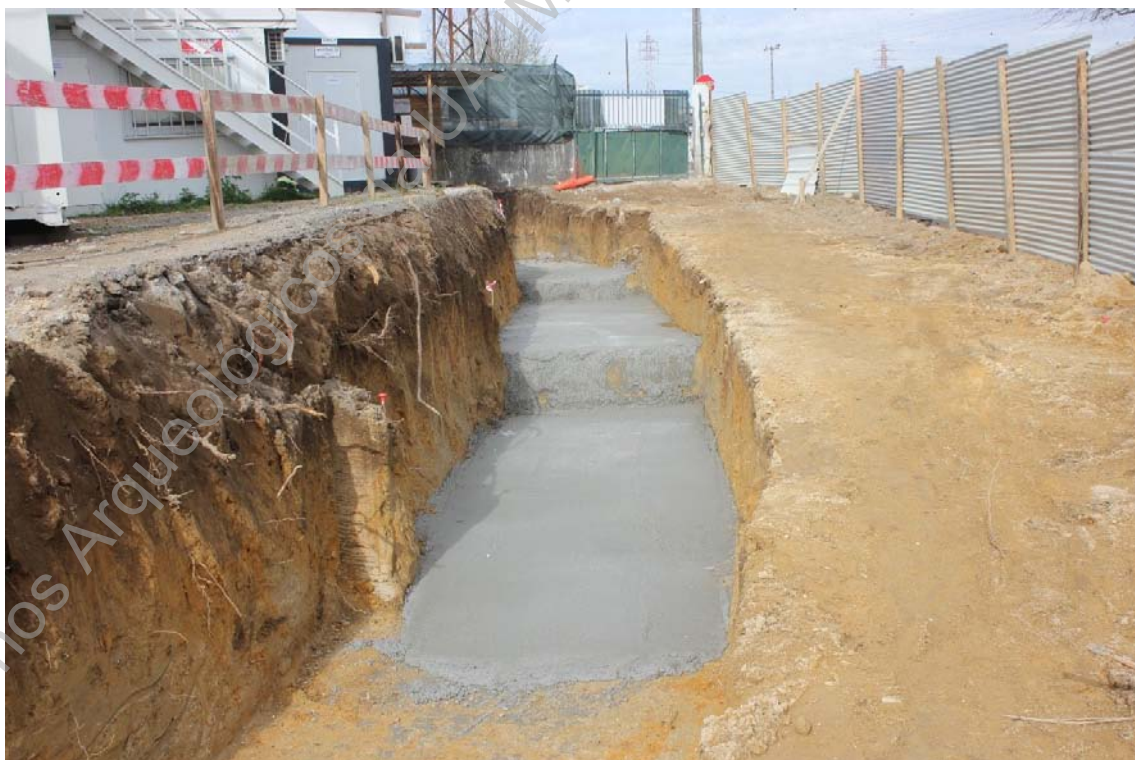
Foto 26 (IMG_6291) –Aplicação do betão de limpeza na vala aberta durante o acompanhamento.
