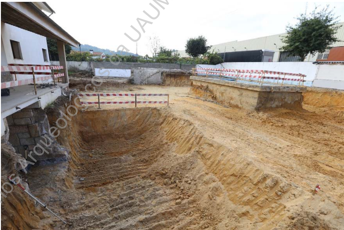
Foto 18 (IMG_2254) –Perspetiva geral dos perfis sul e oeste da sondagem 2
