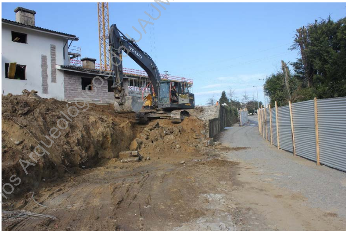
Foto 20 (IMG_5481) – Desmonte do muro delimitador do lote a oeste.
