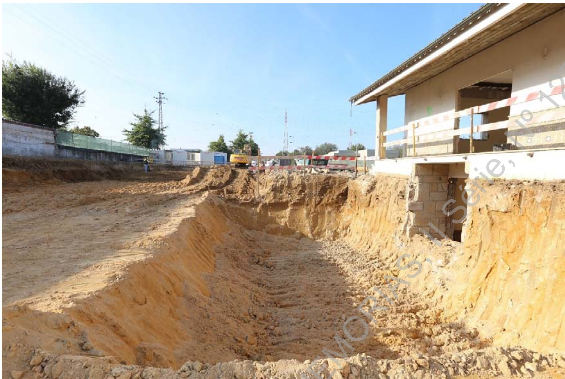
Foto 19 (IMG_2218) – Aspeto geral da finalização da decapagem da sondagem 2.
