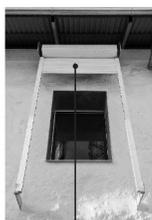
*Sistema de proteção solar afastado do vão e da parede garantindo simultaneamente proteção solar e visibilidade interior-exterior.*
