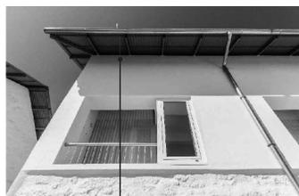
*Cobertura contínua deslocada para a cota do beiral e recuo da porta de entrada, deixando de estar à face da fachada. Permite assim a utilização de todos os bancos e uma maior proteção da porta.*
