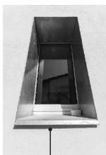
*Recuo da janela para uma posição interior e aumento da superfície envidraçada até ao limite do vão. Maximização da luz no interior e possibilidade de colocar objetos como vasos no parapeito pelo exterior.*
