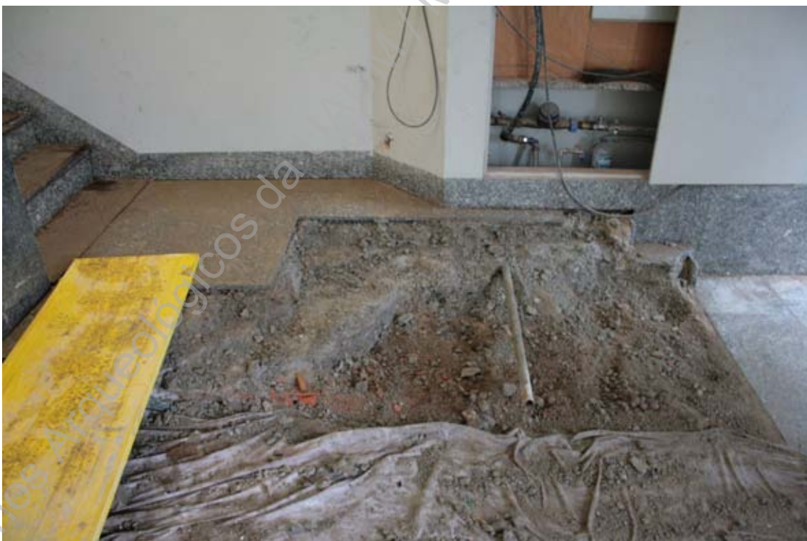
Foto 7 (IMG_5837) – Pormenor do início do trabalho de remoção do piso no rés do chão.
