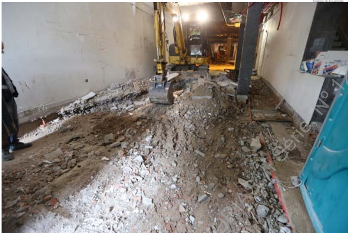
Foto 8 (IMG_8431) – Perspetiva geral do acompanhamento da remoção do piso do rés-do-chão.
