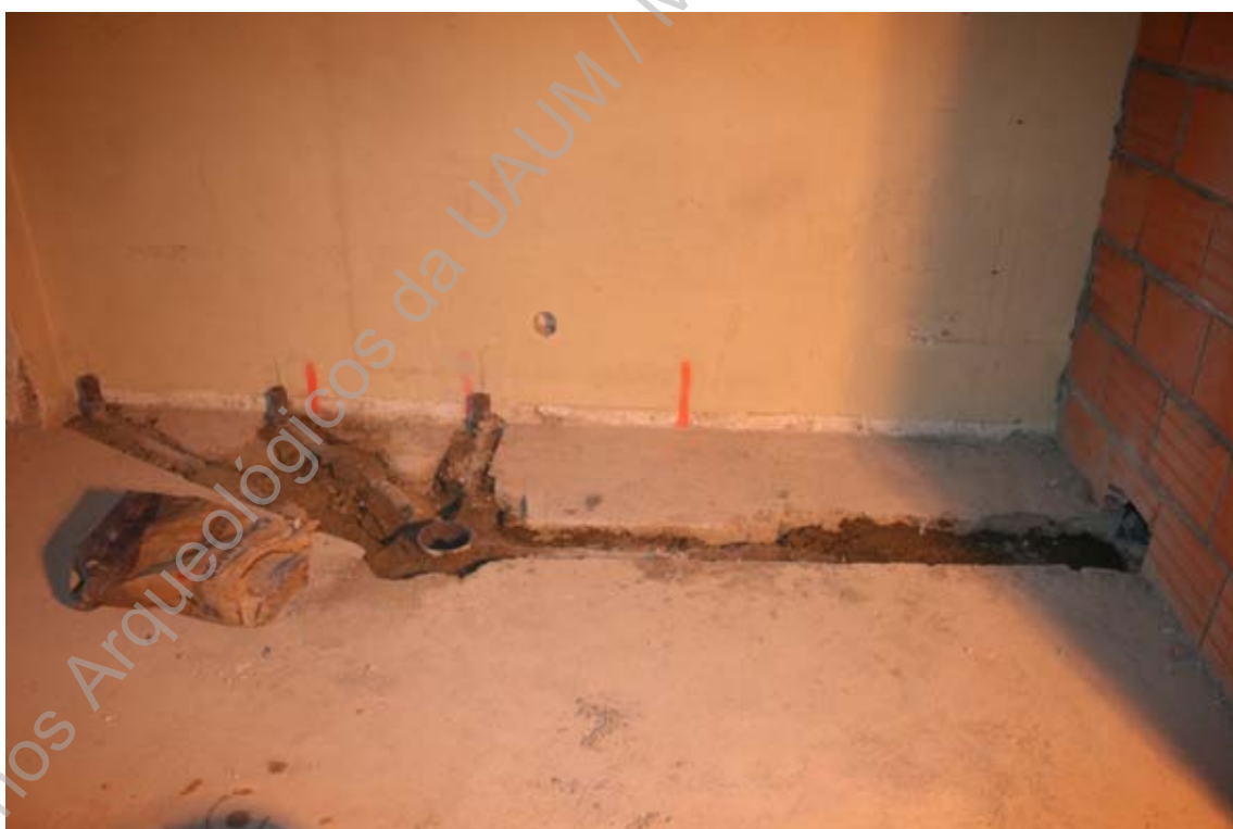
Foto 4 (IMG_5610) – Pormenor da colocação de tubagem.
