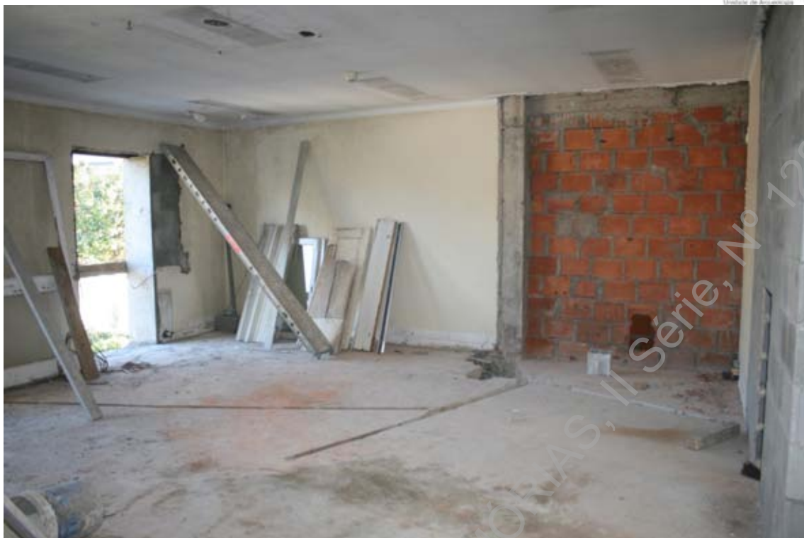
Foto 3 (IMG_5585) – Perspetiva geral da abertura no pavimento em cimento para colocação de tubagem.
