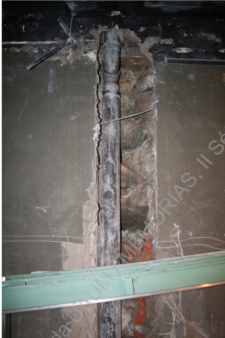
Foto 5 (IMG_5617) – Pormenor da abertura para colocação de tubagem no rés do chão do edifício.
