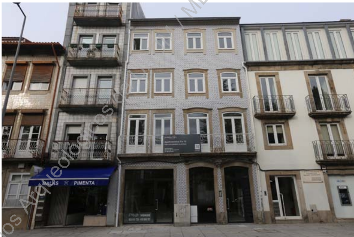
Foto 11 (IMG_4849) – Aspeto final da fachada do edifício localizado na Avenida Central n.ºs 157-163, Braga.
