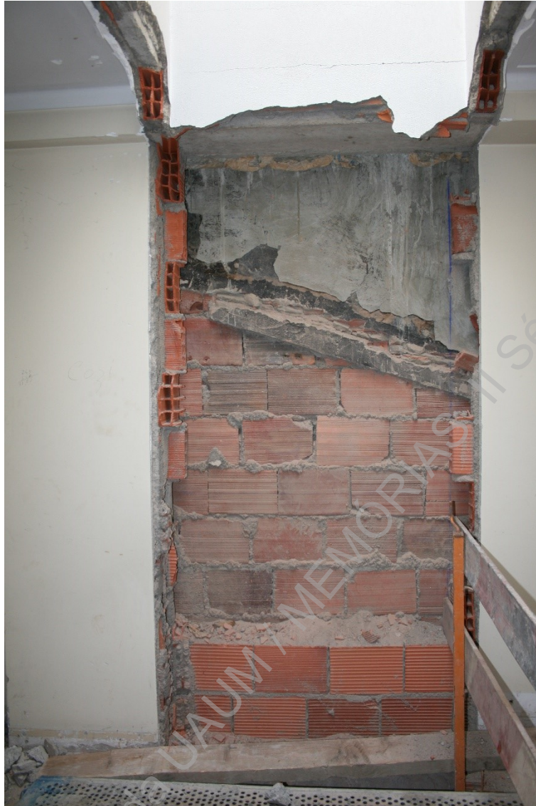
Foto 2 (IMG_5592) – Pormenor da remoção do estuque para colocação de tubagem.
