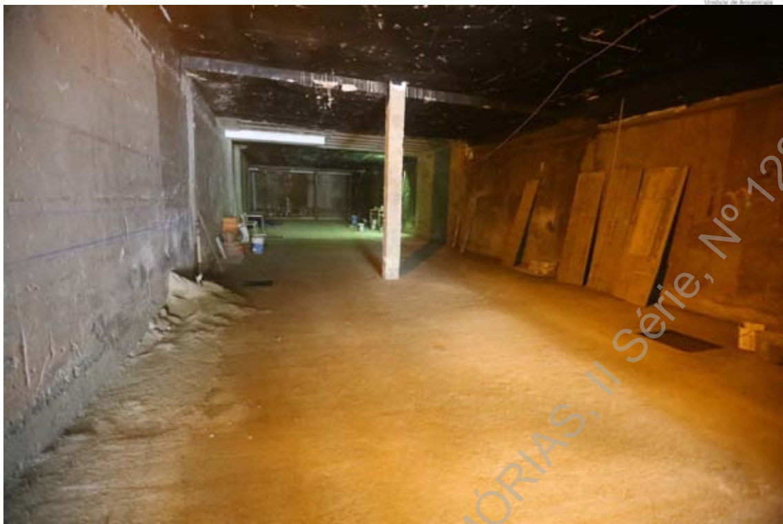
Foto 10 (IMG_4832) – Aspeto final da área intervencionada.
