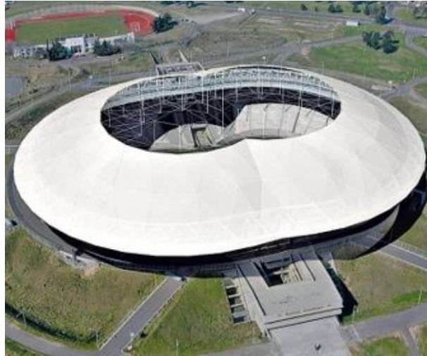
Fig. 4.14. Exemplo de uma estrutura tensionada por cabos (Estádio La Planta, Argentina). 107
