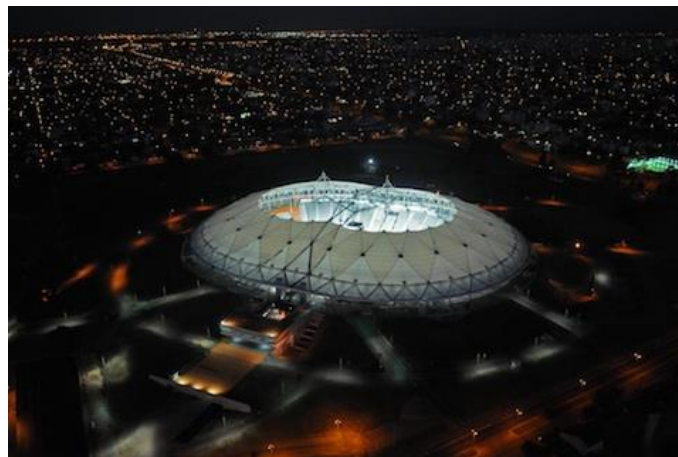
Fig. 2.5. Exemplo de uma aplicação de revestido a PVC na Arquitectura Têxtil. 11
