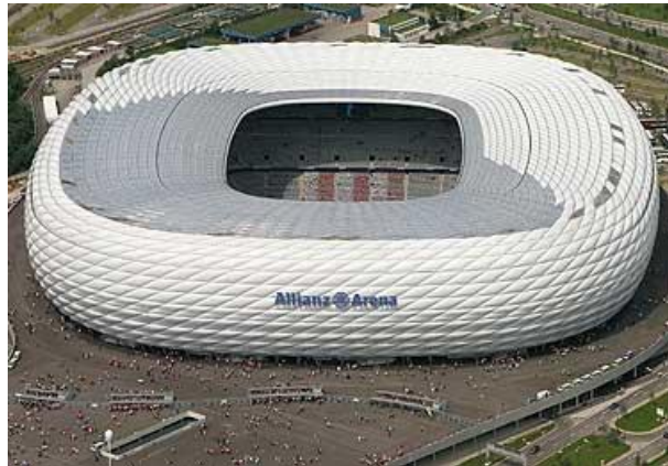
Fig. 4.15. Exemplo de uma estrutura tensionada pneumática (Allianz Arena, Alemanha). 108
