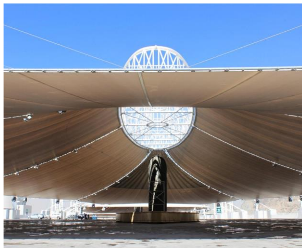
Fig. 4.16. Exemplo de uma estrutura tensionada de membrana têxtil (Ponte Jamarat, Arábia Saudita). 109
