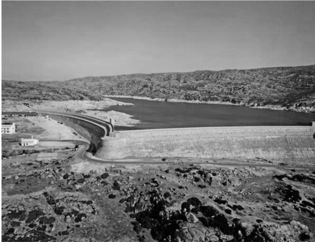
Figura 5.6 – Vista de montante da Barragem da Lagoa Comprida
