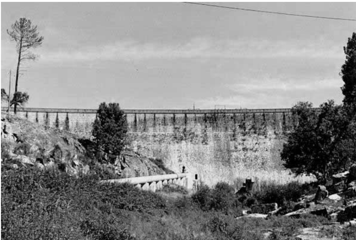
Figura 6.10 – Vista geral da Barragem da Póvoa (corpo principal)
