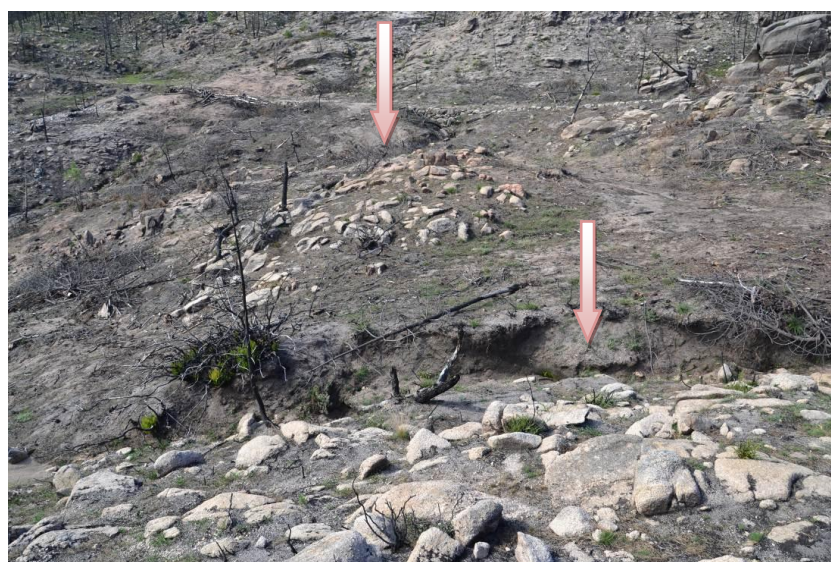
Fotografia 1. Área selecionada para implementação das medidas de mitigação da erosão em canais. (Sinalizadas com setas as linhas de circulação de água intervencionadas)
