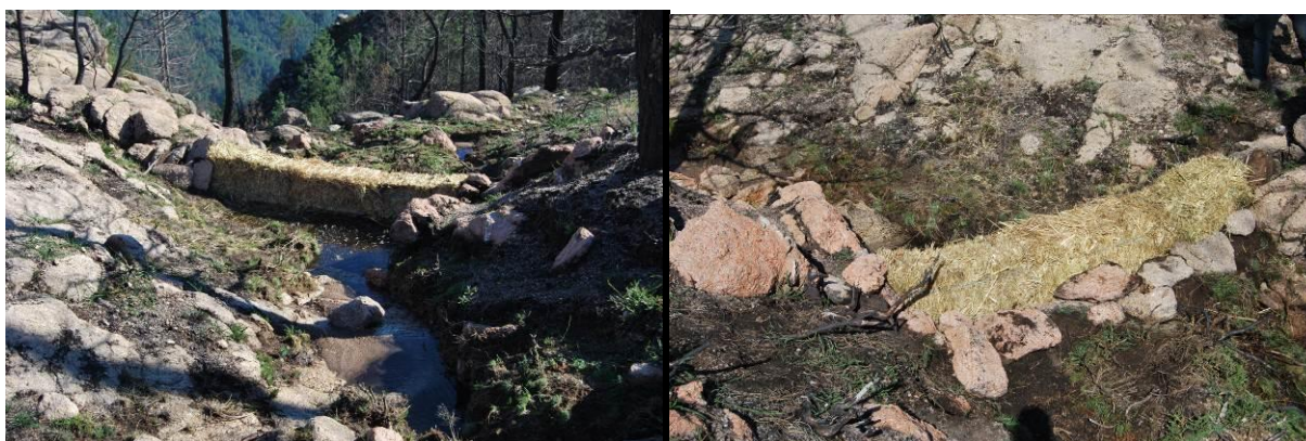
Fotografia 3A e 3B. Barreira de fardos de palha.
