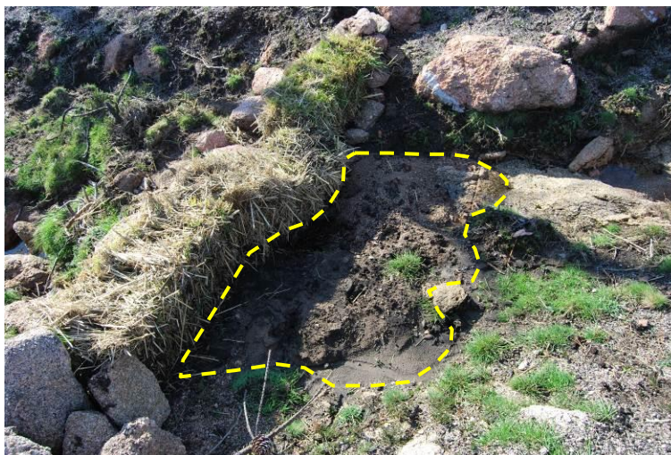
Fotografia 5. Acumulação de sedimentos na barreira de fardos de palha (limite pela linha tracejada).
