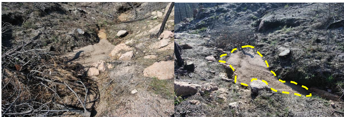
Fotografia 7A e 7B. Acumulação de sedimentos em barreira de restos do corte dos pinheiros ardidos e caruma.
