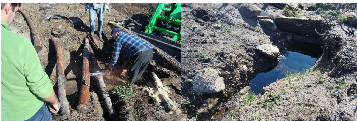
Fotografia 2A e 2B. Construção de barreiras de troncos.
