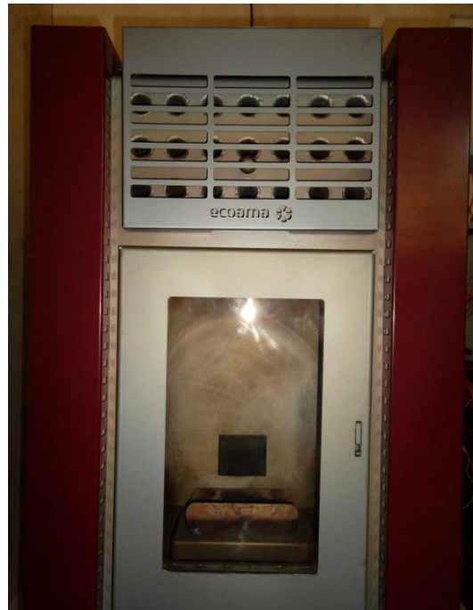
Figura 3.16 – Permutador de calor.
