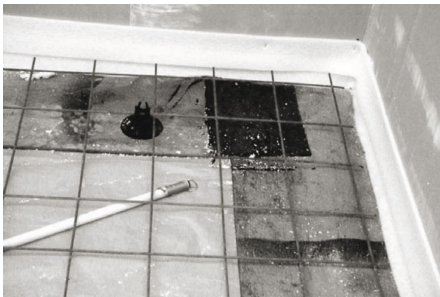
Figura 3: Feltro betuminoso colocado antes da betonagem da laje térrea [12]
